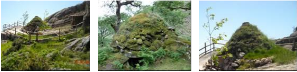
Figura 3.13: Exemplan cabana de pastor construída em pedra e torões
