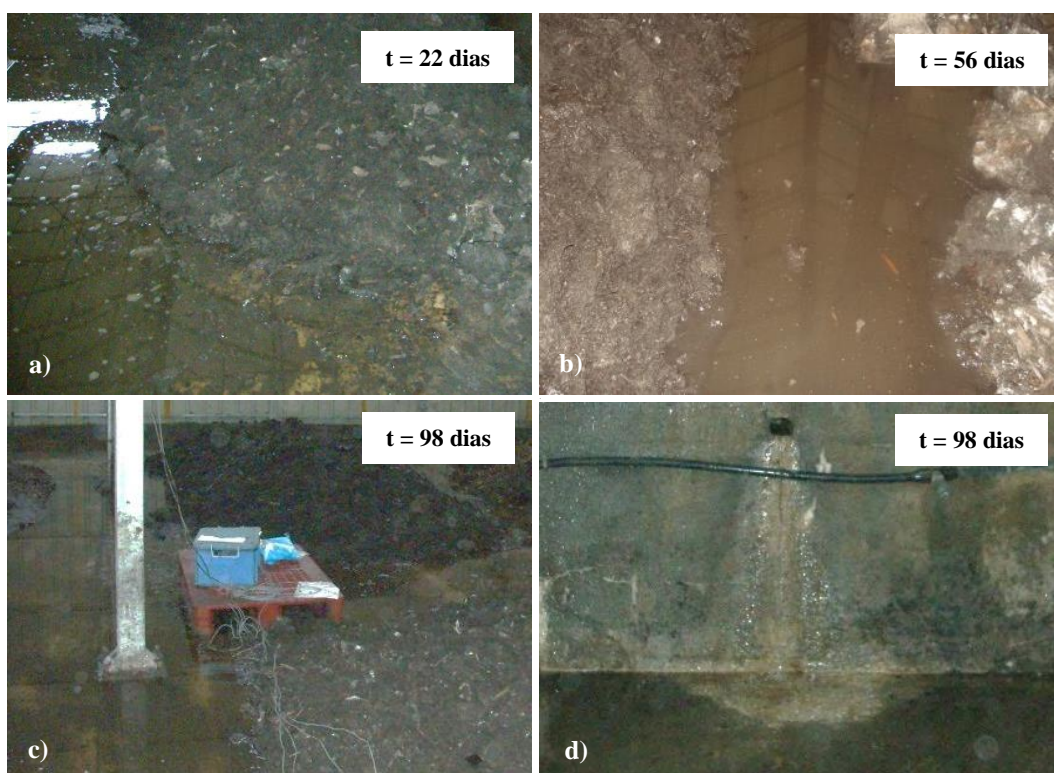
Figura 7.3. Quantidade de água presente nas instalações: a), b) e c) quando se construíram novas pilhas (pilhas vizinhas); d) água afluyente resultante da recolha de águas pluviais.
