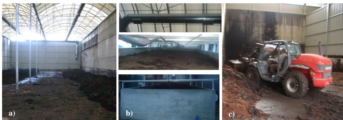
Figura 6.3. Empresa Gintegral – Gestão Ambiental, S.A : a) edifício onde se construíram as pilhas de compostagem; b) sistema de remoção de odores c) mini giratória.
