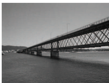
Fig. 2.8 – P. em viga treliçada: Ponte V. do Castelo
