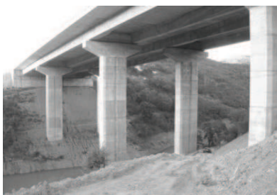
Fig. 2.6 – P. em viga simplesmente apoiada: Viaduto Messines
