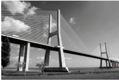
Fig. 2.11 - Ponte atirantada: Ponte Vasco da Gama
