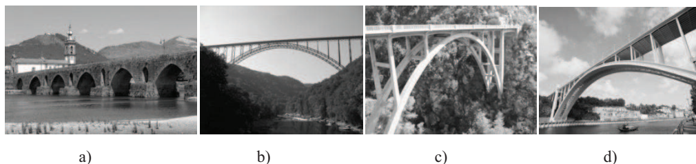
Fig. 2.10 – Alguns exemplos de pontes em arco: a) Ponte de alvenaria Romana em P. de Lima; b) Ponte de aço: New River Gorge nos EUA; c) Ponte de betão Angeles Forest nos EUA; d) Ponte da Arrábida no Porto.
