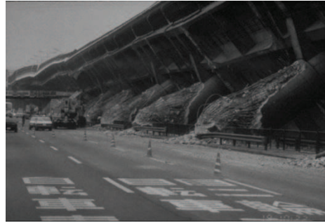
Fig. 2.22 – Colapso de um viaduto devido à dispensa prematura das armaduras longitudinais dos pilares [4]
