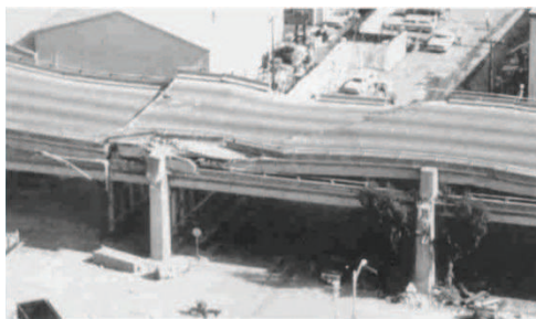
Fig. 2.24 - Falha nos nós. [11]
