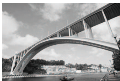
Fig. 2.3 - Ponte da Arrábida, Portugal.
