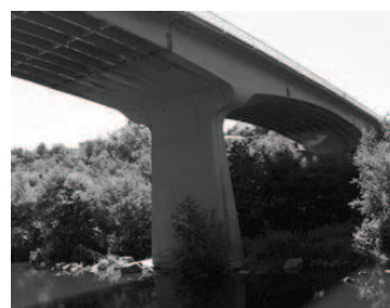
Fig. 2.9 - Ponte em Viga Gerber: Ponte de Amarante
