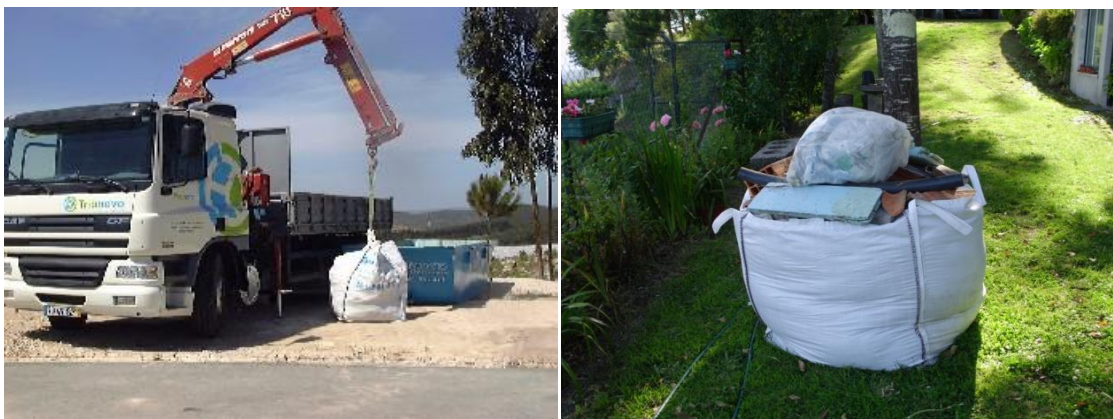
Figura 2.4 - Armazenamento e recolha de RCD em Big bags (fonte do autor)
