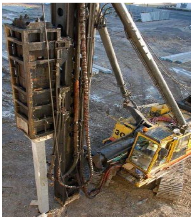
Figura 5 Exemplo de cravação de estaca pré fabricada de betão armado (Jorge Paulo 2008)
