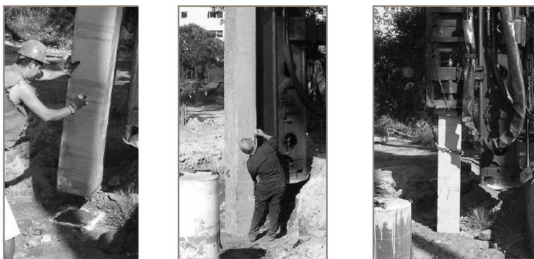
Figura 1 Execução das estacas cravadas pré-fabricadas (Esteves, 2005)
