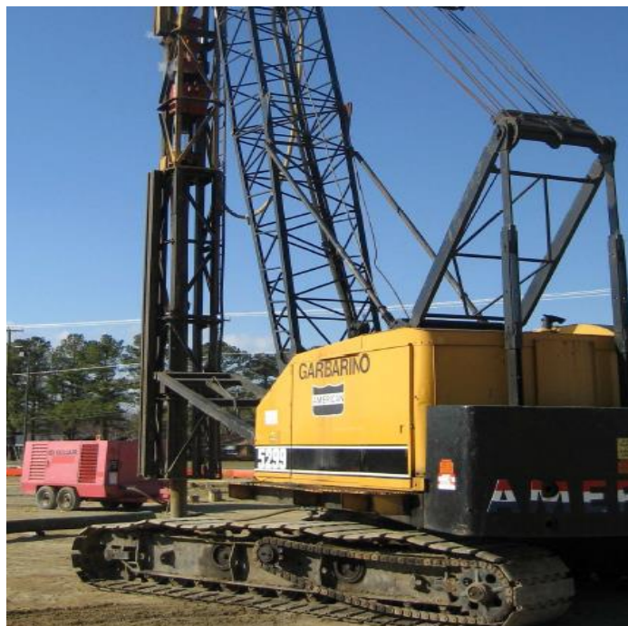
Figura 3 Representação típica de cravação de estacas de madeira (Jorge Paulo 2008)
