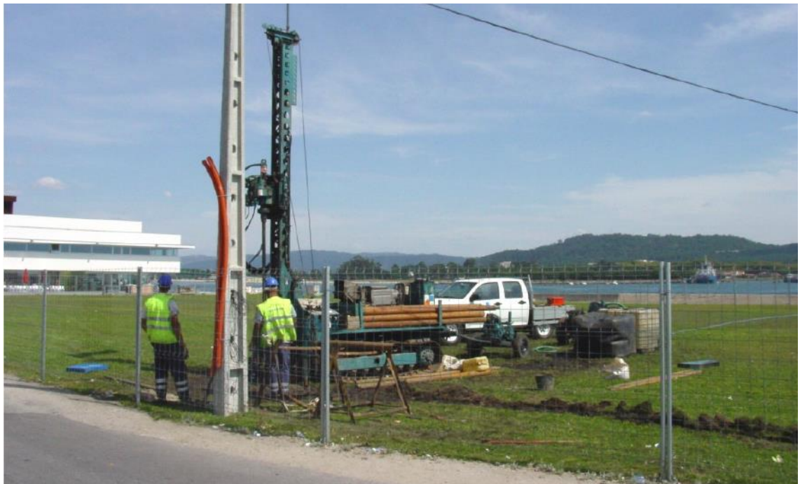
Figura 7 Aspeto da execução dos trabalhos de prospecção geotécnica (Mota-Engil)
