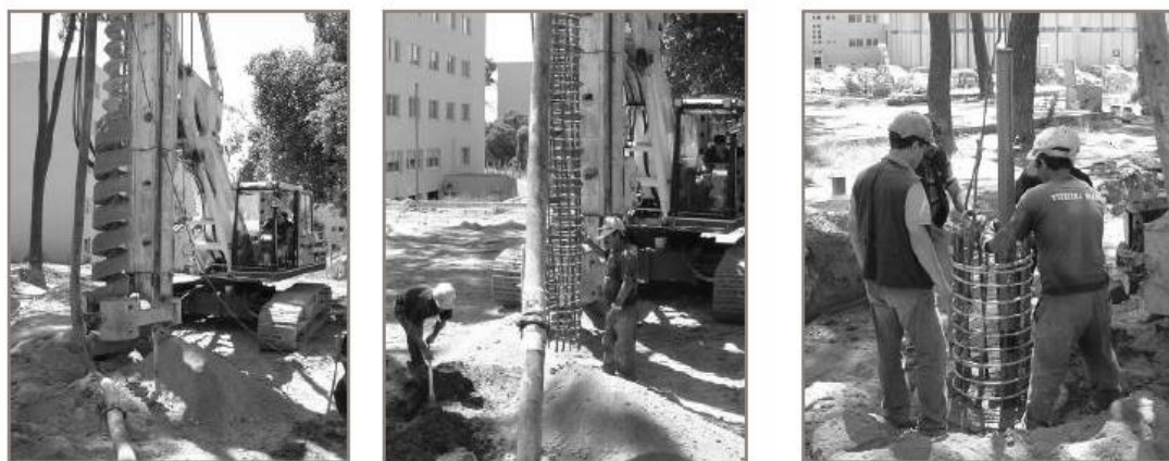
Figura 2 Execução das estacas moldadas (Esteves, 2005)
