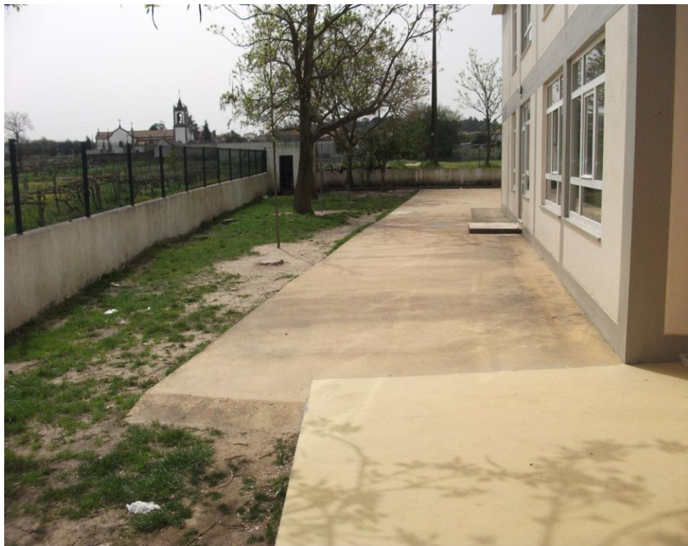
Figura 4. Área em cimento da parte de trás da escola.
