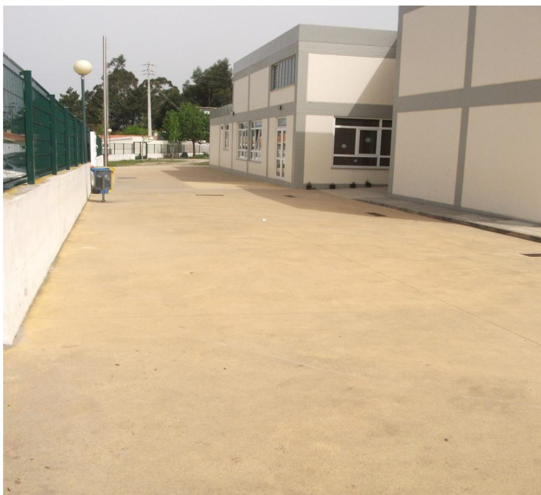
Figura 2. Área em cimento da parte da frente da escola.
