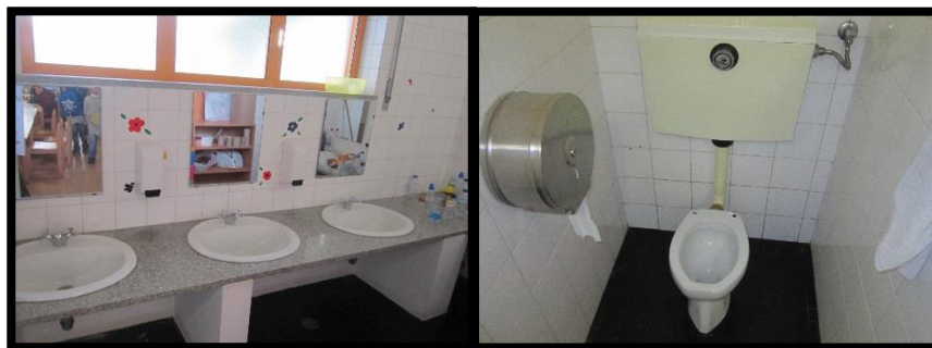
Figura 4. Sanitários incluídos na sala de atividades
