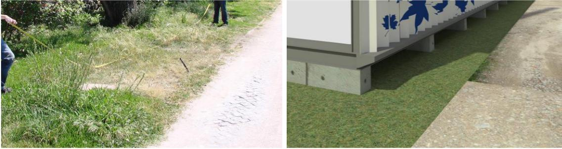
Figura 30 – *Da esquerda para a direita*: Pormenor fotográfico da zona onde vai ser instalada a estrutura, com especial interesse numa das tampas de saneamento visíveis, por baixo da fita de medição. Pormenor de um render da instalação da estrutura, com os blocos de betão, criando altura suficiente de acesso às tampas.
