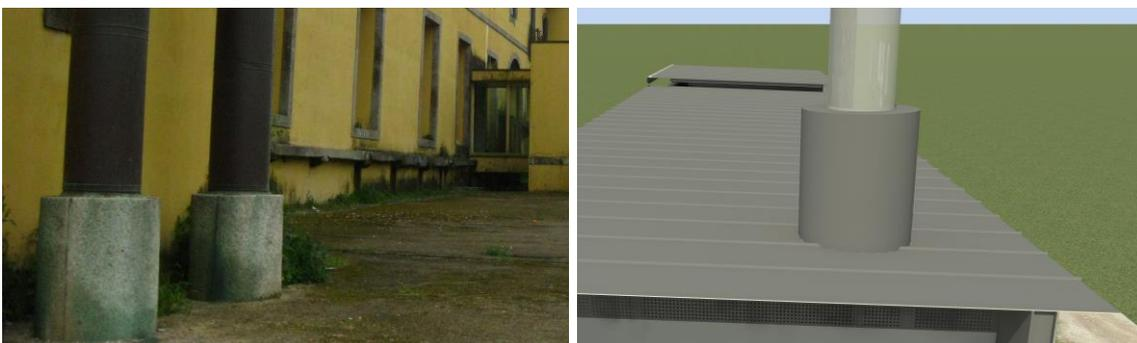
Figura 31 – *Da esquerda para a direita*: Pormenor fotográfico da base das chaminés do mosteiro. Pormenor em render da base da chaminé da estrutura projetada. (Imagens do autor)
