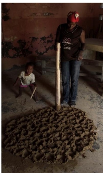
Figura 8 - Homogeneização da pasta com pau de "sobá" barro.
