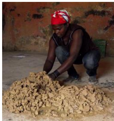
Figura 7 - Homogeneização da pasta com as mãos
