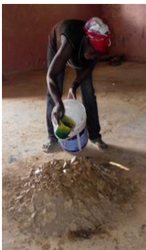
Figura 6 - Adição de água.
