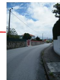
3) Estrada que dá acesso ao restaurante: "Vianinha"
