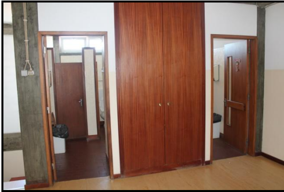
Figura 10 - Casas de banho
