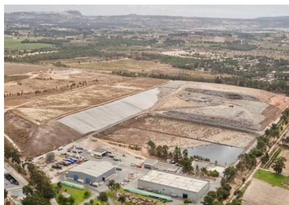
Figura 2.6 - Aterro Sanitário de Palmela (Fonte: AdP)
