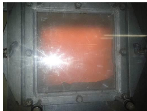
Figura 4.11 - visor do queimador Central de Valorização Energética
