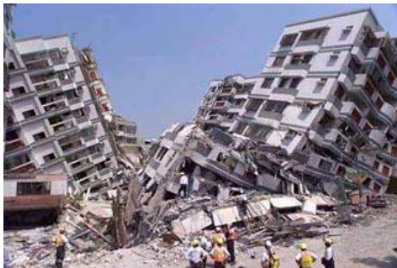
Figura 2.6 Desmoronamento de edifícios de grande altura (Taiwan, 1999)
