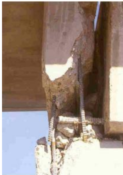
Figura 2.9 Dano em um nó de ligação (Northridge, 1994)
