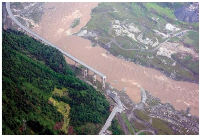
Figura 2.7 Queda de um viaduto (Wenchuan, 2008)
