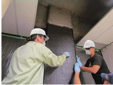
Figura 4.7 Pilar reforçado com recurso a mantas de carbono
