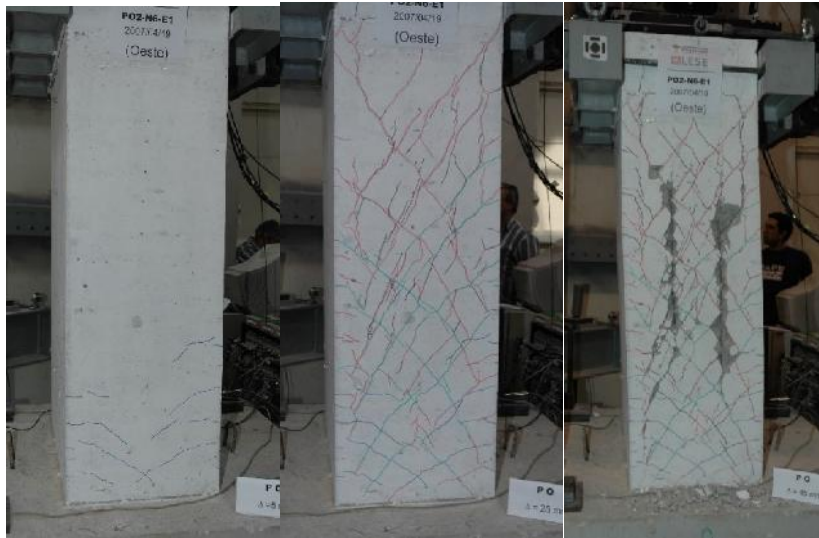
a) Início de fendilhação b) Rotura Convencional c) Esmagamento do betão Figura 3.38 Exemplificação de alguns danos observados
