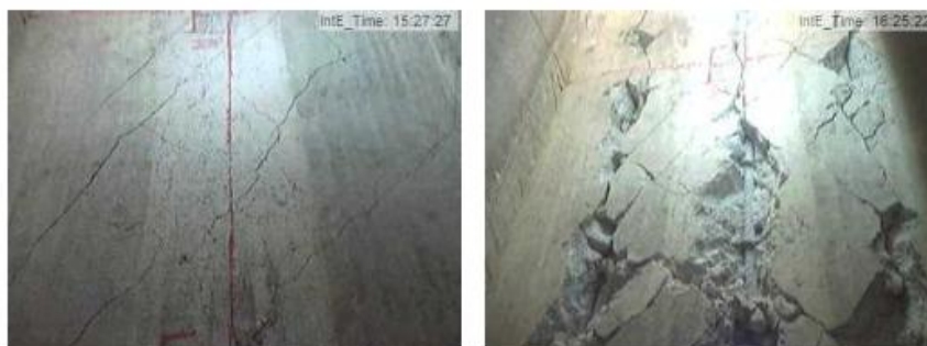
a) Drift 0.93% b) Drift 2.14% Figura 3.11 Danos nas faces interiores PO1-N4
