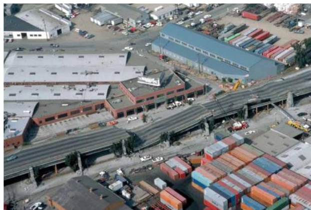
Figura 2.3 Queda do viaduto de Cypress (Loma Prieta, 1989)
