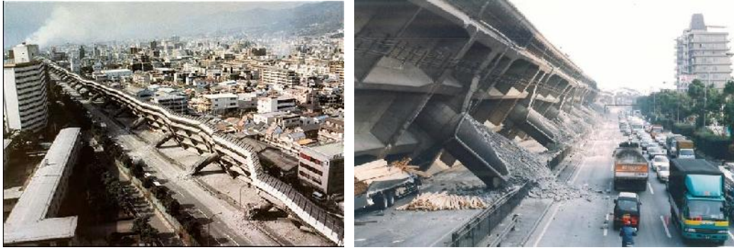
Figura 2.5 Danos sofridos no viaduto do Hanshin Expressway (Kobe, 1995)
