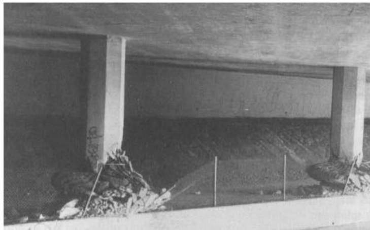
Figura 2.23 Formação de rótulas plásticas junto à base (Northridge, 1994)
