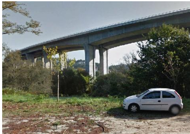
Figura 2.41 Ponte sobre o Rio Coura
