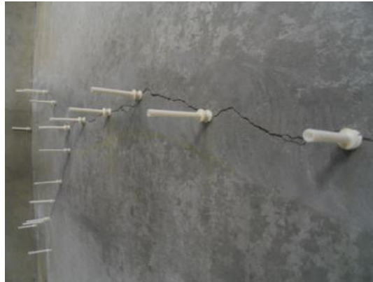
Figura 4.2 Execução de injeção de resina epóxy
