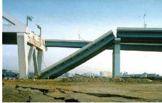
Figura 2.15 Rotura devido à rotação dos tabuleiros
