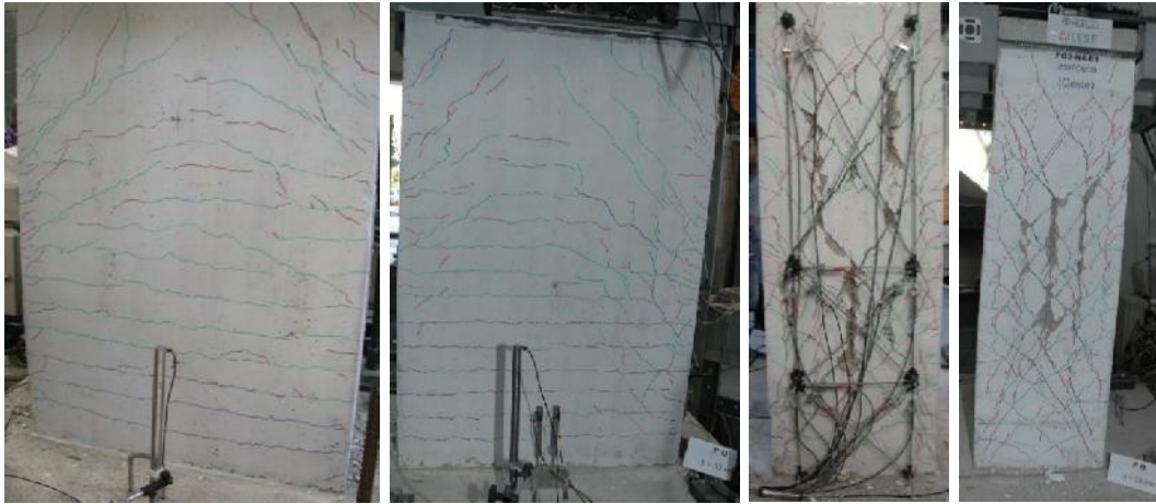
a) Face Norte b) Face Sul c) Face Este d) Face Oeste Figura 3.24 Danos no pilar PO2-N4 no final do ensaio
