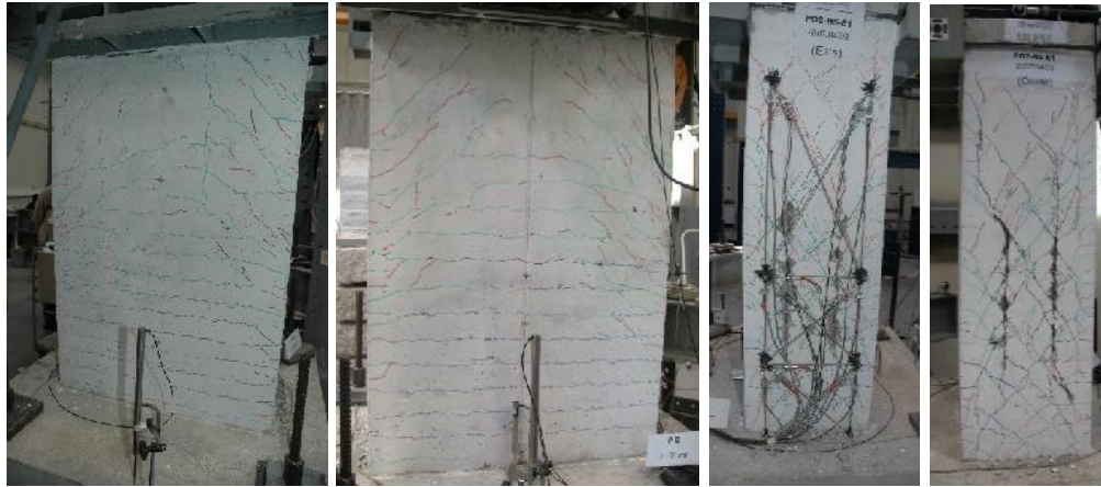
a) Face Norte Figura 3.28 b) Face Sul Dano do pilar PO2-N5 no final do ensaio c) Face Este d) Face Oeste
