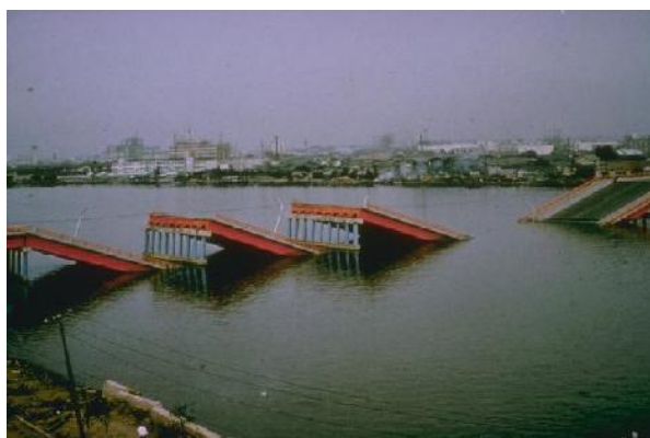
Figura 2.1 Queda da Ponte de Shawo devido ao efeito de Liquefação do solo (Niigata, 1964)
