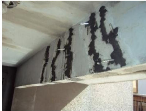
Figura 4.3 Resultado após injeção de resina epóxy
