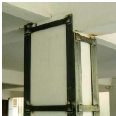
Figura 4.6 Pormenor das chapas metálicas adicionadas
