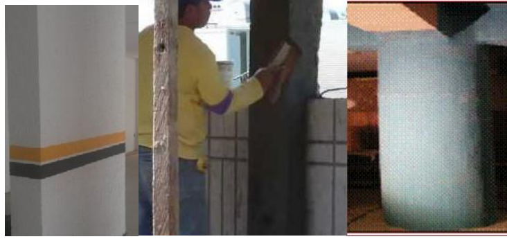
Figura 4.1 Técnicas de reparação superficial de pilares (pintura-rebocar-esfregar resina epóxy )
