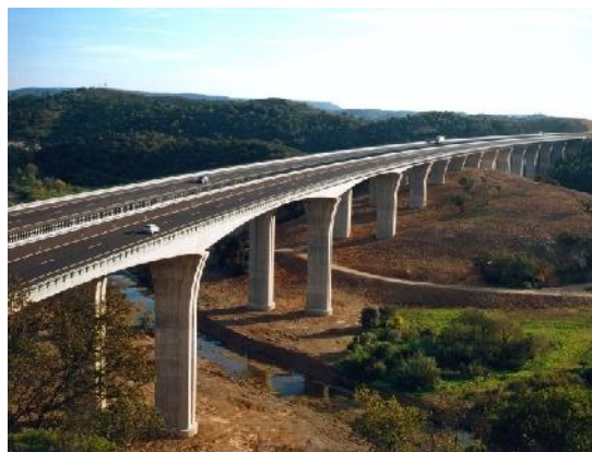
Figura 2.44 Viaduto sob o rio Arade
