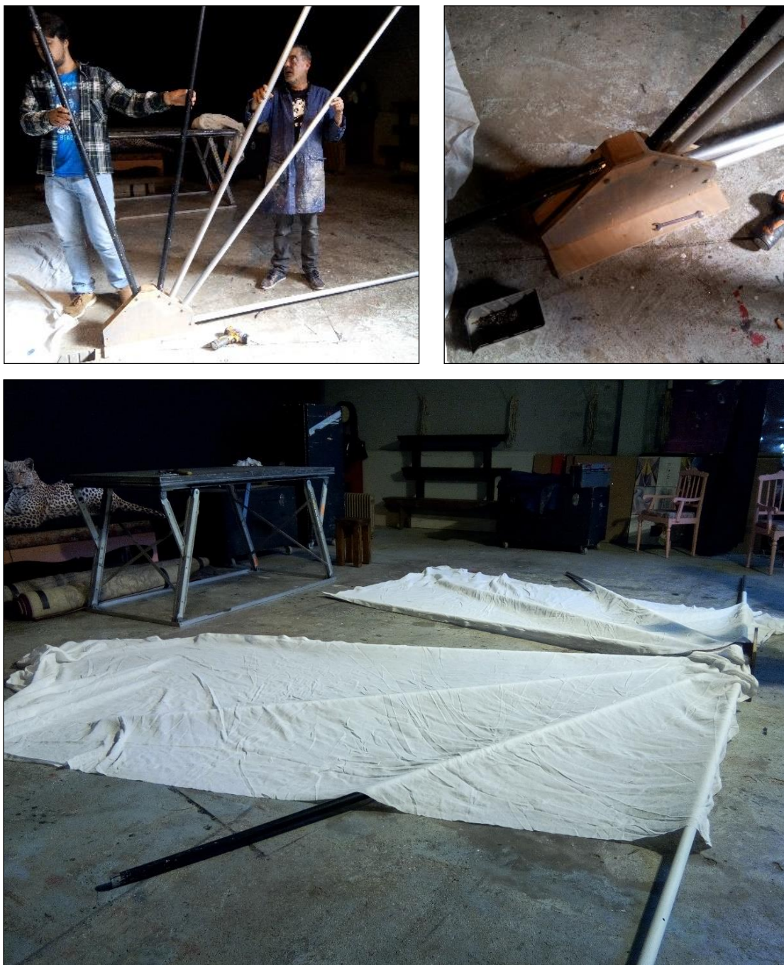
Figura 24: Da esquerda para a direita e de cima para baixo. Base já com os tubos encaixados. Base já com os tubos encaixados. Base com os tubos distribuídos de igual forma e com os panos. Foto de Autor: Andreia
