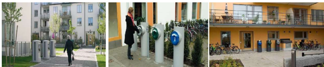
Figura 2-30 - Sistema de entrega de RU no exterior de edificios (Envac - Automated Waste Collection)
