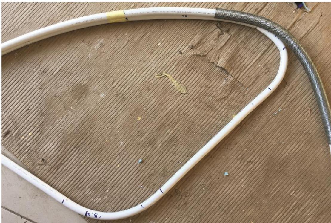
Figura 55 – Processo de dobragem do tubo
