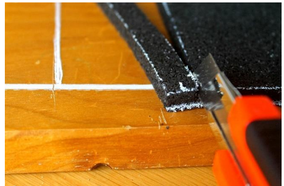
Figura 51 - Corte das interseções da Softbase
