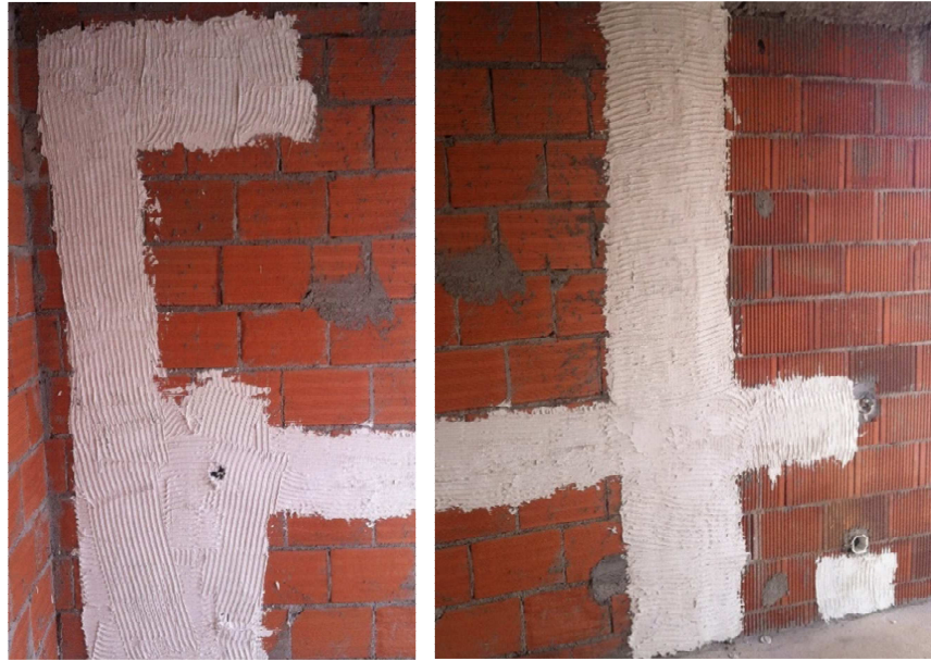
Figura 4.2 - Tratamento de roços provenientes da passagem de instalações técnicas.
