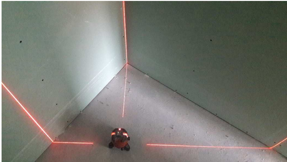
Figura 4.16 - Marcação de alinhamentos e esquadrias com auxílio de laser.
