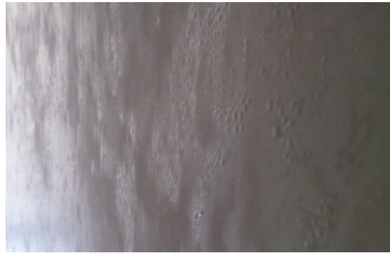
Figura 4.14 - Processo de secagem do revestimento em gesso
