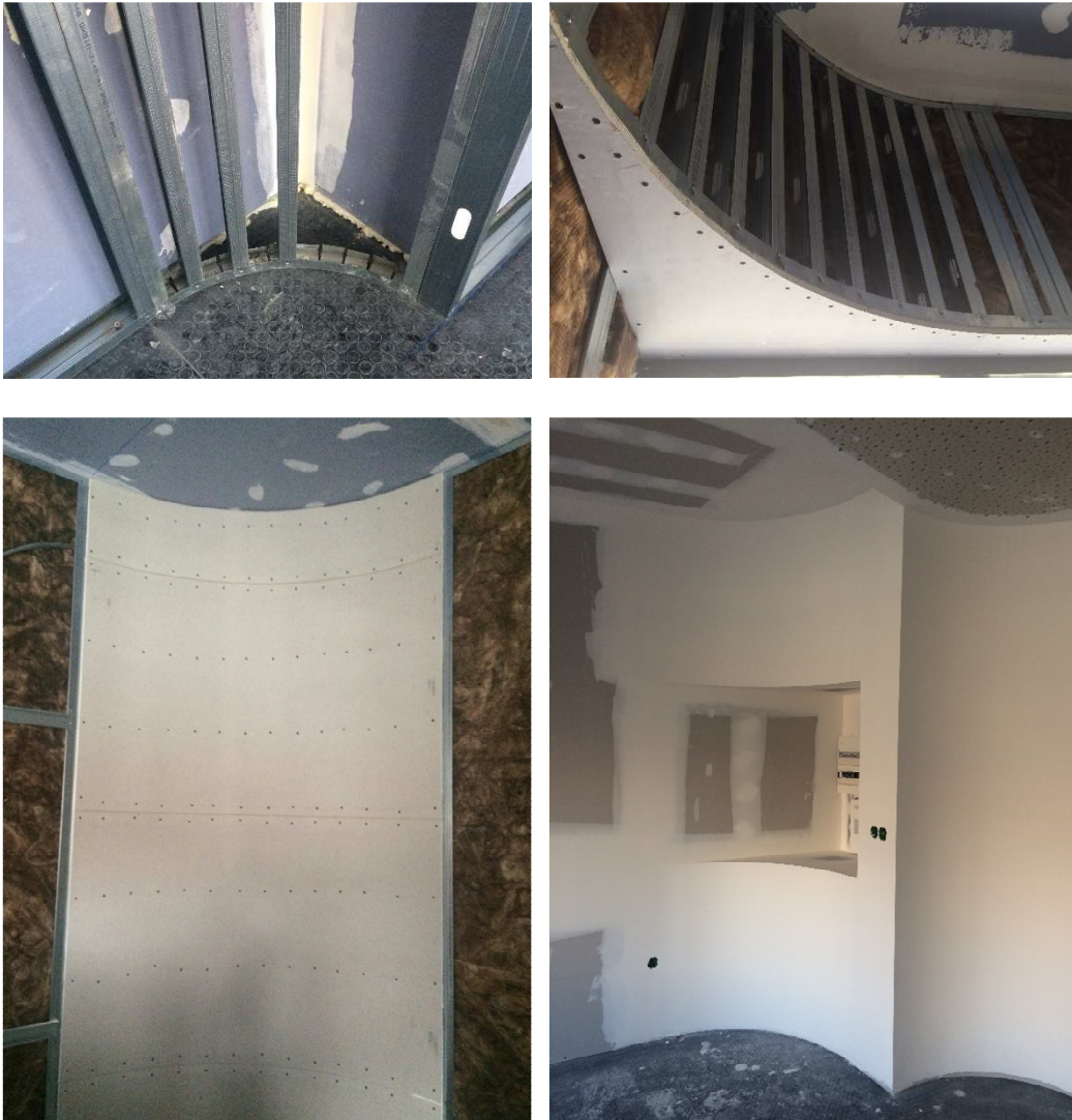
Figura 4.24 – Exemplos de adaptação arquitetónica do sistema autoportante em gesso cartonado.
