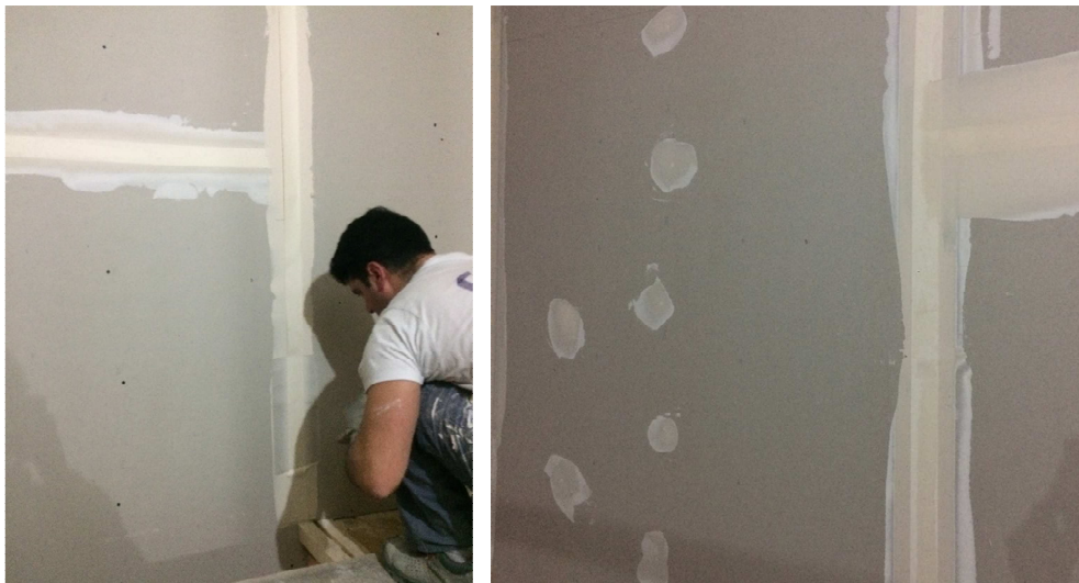
Figura 4.22 - Colagem de fitas e tratamento de juntas e parafusos.
