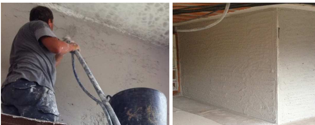
Figura 4.7 - Projeção de gesso em camadas horizontais sucessivas.
