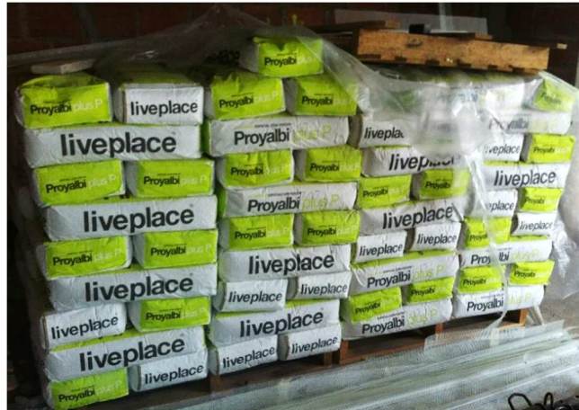
Figura 4.6 – Acomodação em obra de gesso pré-doseado, do tipo Proyalbi Plus ou equivalente
