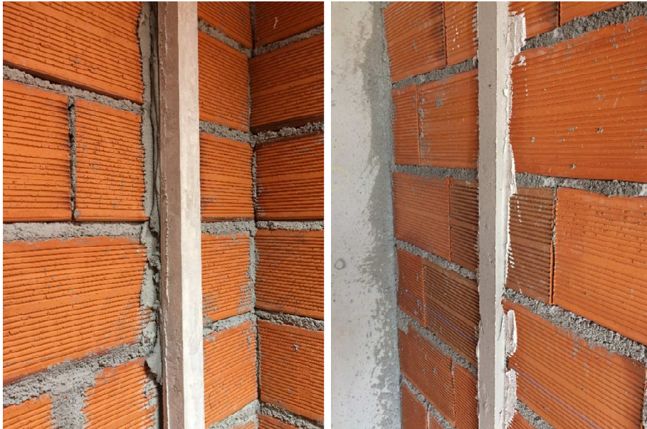
Figura 4.3 - Execução de mestras em gesso com o apoio de régua cainho.
