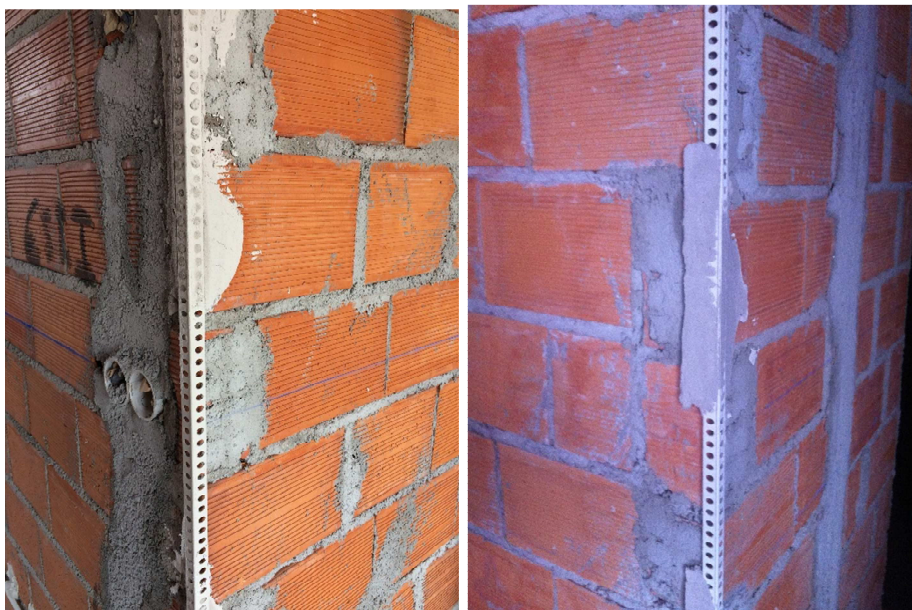
Figura 4.4 - Colocação de perfis de esquina perfurados em PVC, nos vértices exteriores.
