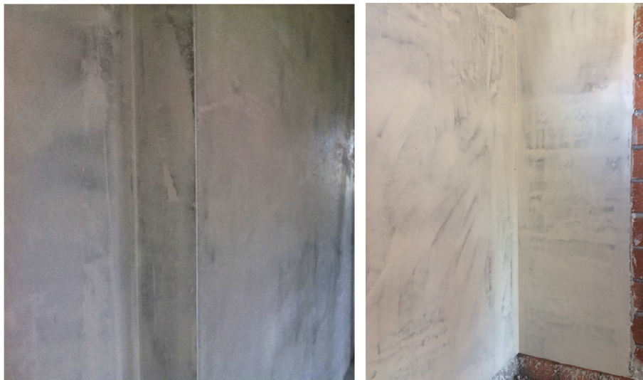
Figura 4.13 - Revestimento após a aplicação de camada de acabamento do tipo Albiplas Fino ou equivalente.
