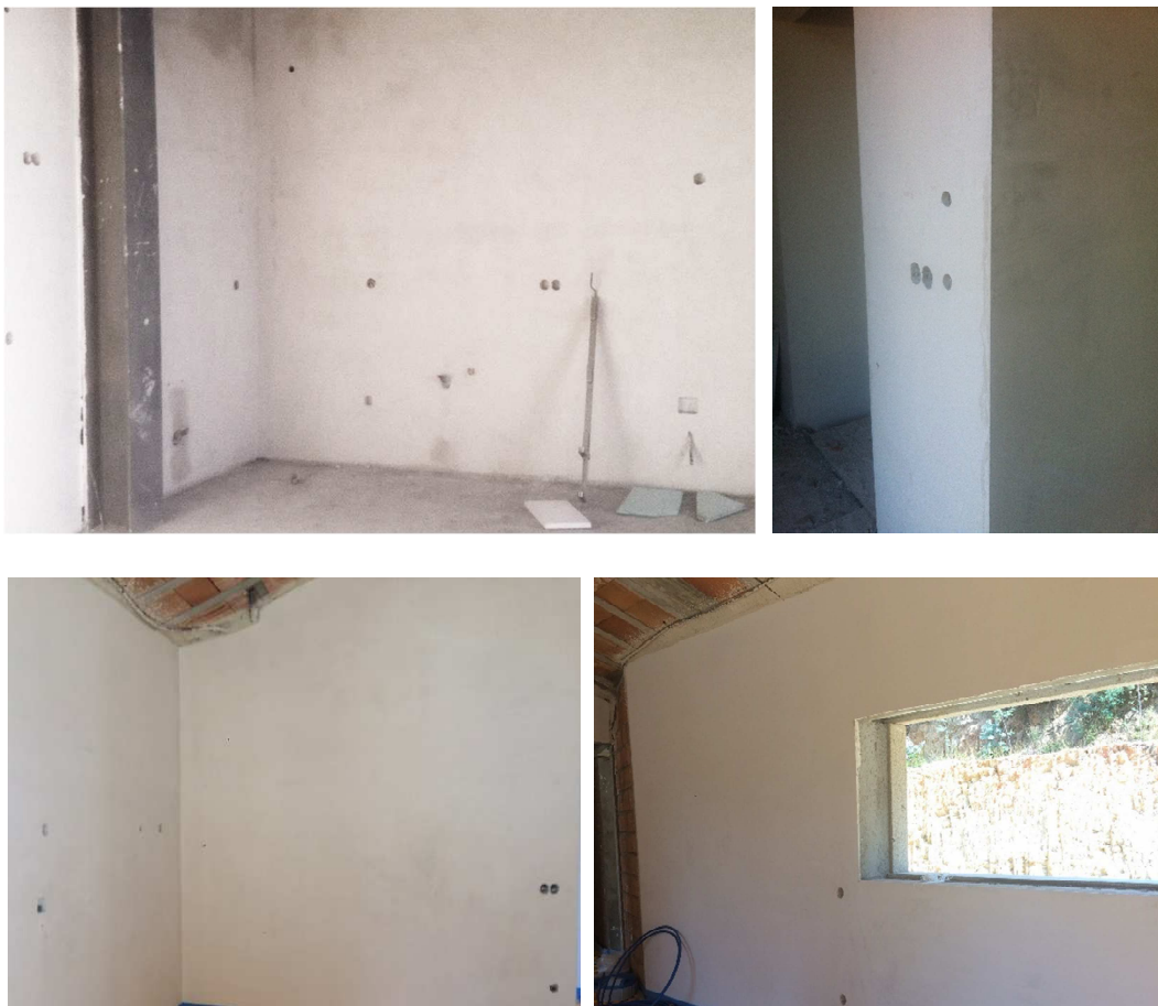
Figura 4.15 – Aplicação do revestimento em gesso projetado concluído
