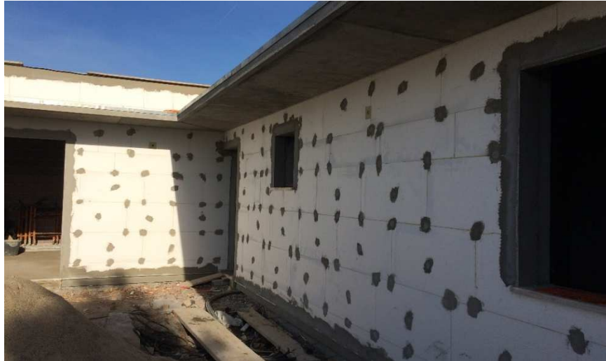
Figura 3.5 - Sistema do tipo weber therm classic , na moradia tida como Caso de Estudo II
