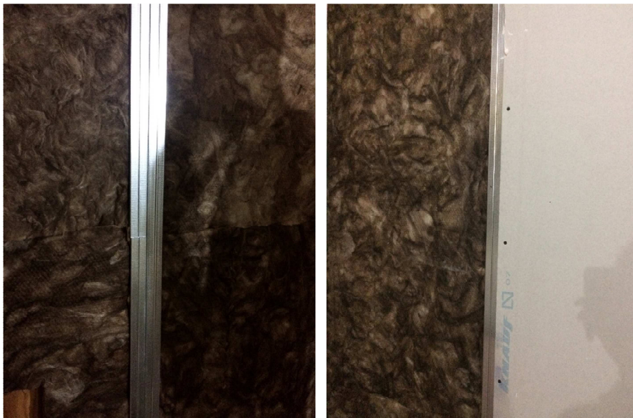
Figura 4.23 - Colocação do material térmico e acústico entre a estrutura metálica.
