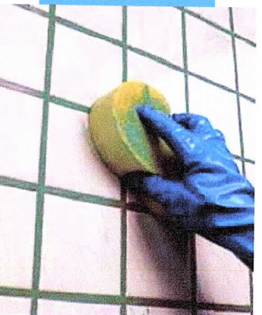
Limpeza e acabamento das juntas em parede com esponja
