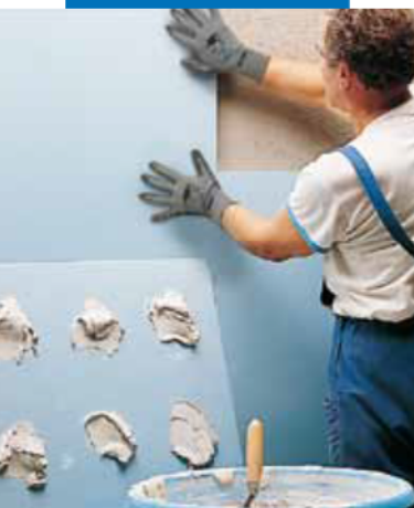
Aplicação de lastras em poliestireno com Keraflex branco
