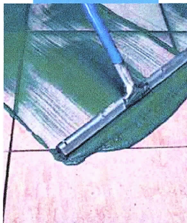
Aplicação do Ultracolor Plus em pavimento com rodo
