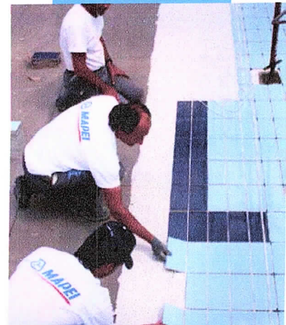
Assentamento de revestimento cerâmico sobre Mapelastic
