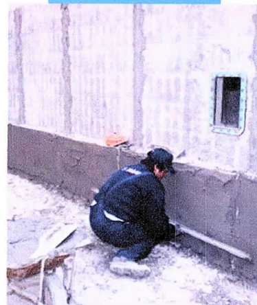
Regularização do reboco com régua
