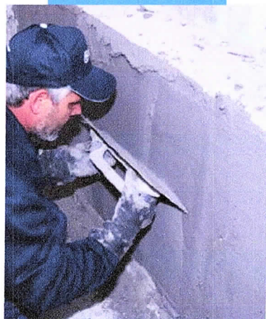
Aplicação de Nivoplan à talocha
