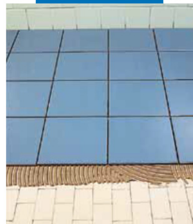
Assentamento de cerâmica sobre cerâmica preexistente com Keraflex cinzento
