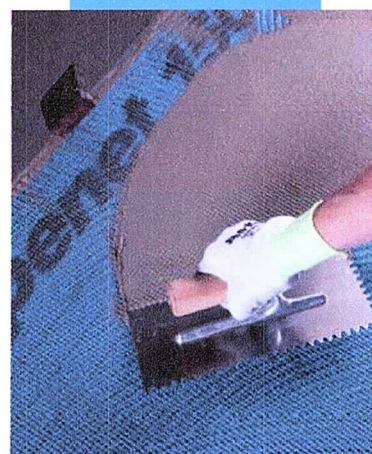
Aplicação de Mapelastic sobre Mapenet 150
