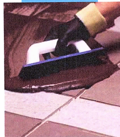
Aplicação do Ultracolor Plus em pavimento com espátula em borracha
