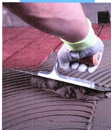
Aplicação de Granirapid sobre um terraço impermeabilizado com Mapelastic
