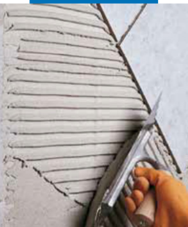
Assentamento em parede de revestimento em monocozedura sobre blocos de betão celular expandido
