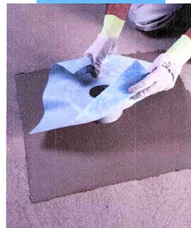
Aplicação de Drain Vertical, ralo de descarga sobre Mapelastic
