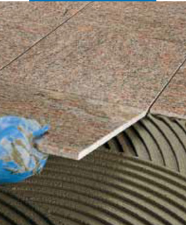
Assentamento em pavimento de mármore prépolido
