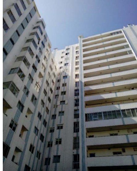
Figura 22 - Alçado Nascente do Edifício.
