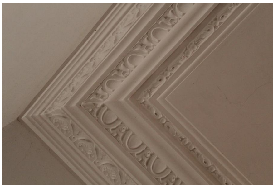
Fig. 13 Interseção de molduras (canto). J.F. Carreço, salão nobre. 2018/11/02
