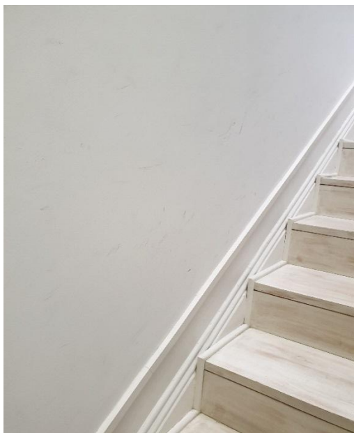
Figura 16: Exemplo de Parede Interna 2
