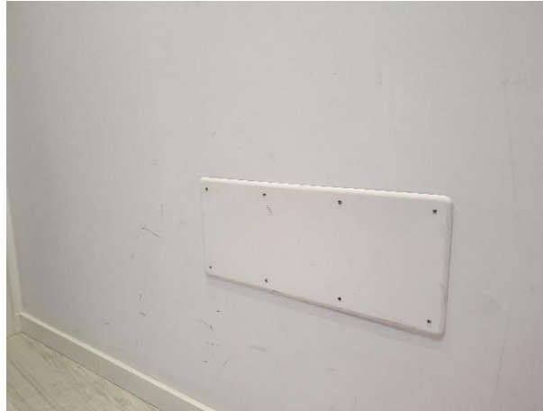
Figura 14: Exemplo de Parede Interna 1
