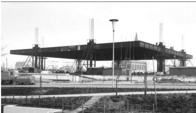
Figura 112-conceito construtivo utilizado para a solução de teto Museu de Berlim (Berlim, Alemanha)
