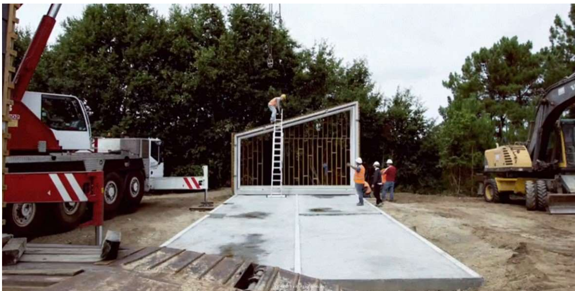
figura 78-ensoleiramento geral para implantar o edifício
