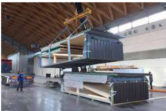
figura 46-módulos preparados para o transporte e a execução da montagem com o auxílio de grua
