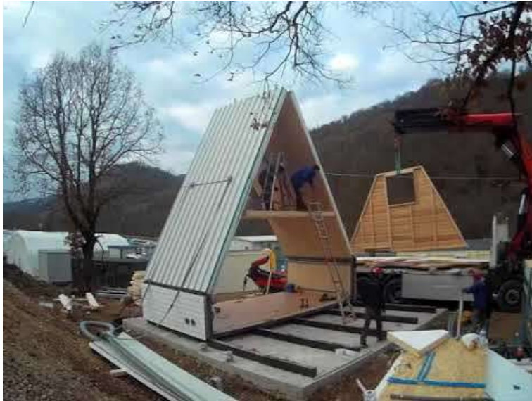
figura 47-montagem com o auxílio de quatro operários e maquinaria pesada
