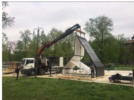
figura 46-módulos preparados para o transporte e a execução da montagem com o auxílio de grua
