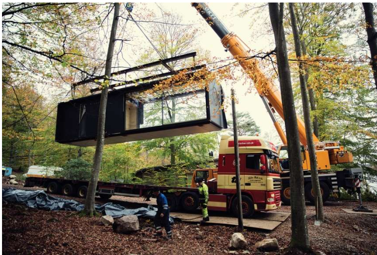
Figura 63-módulo a ser implantado
