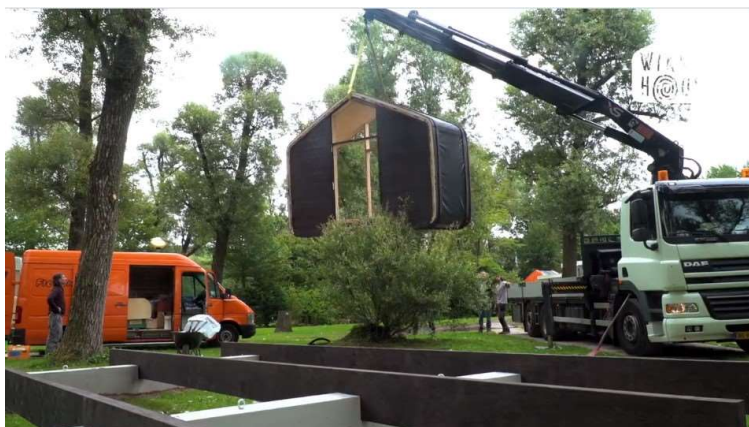
figura 85-módulo a ser implantado
