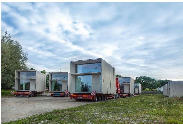
figura 75-módulo a ser transportado por um camião
