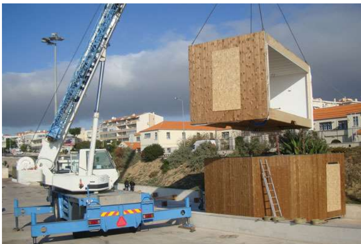
figura 55-necessidade da utilização de maquinaria pesada
