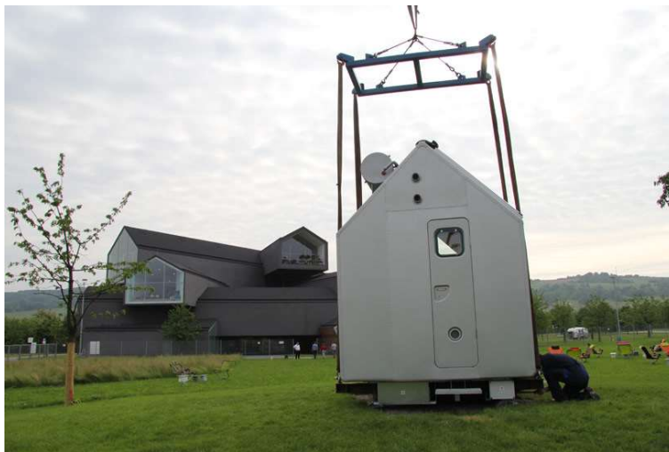
figura 92-módulo compacto a ser implantado
