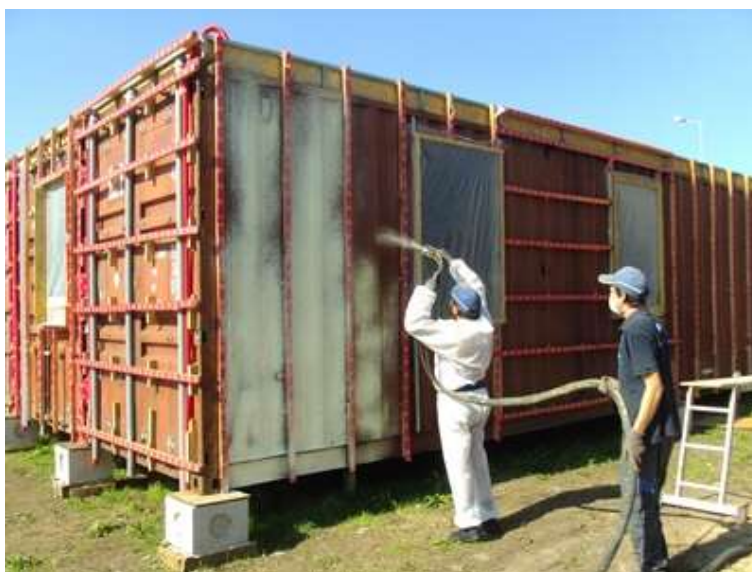
Figura 59-aplicação do isolamento sobre a estrutura do contentor marítimo
