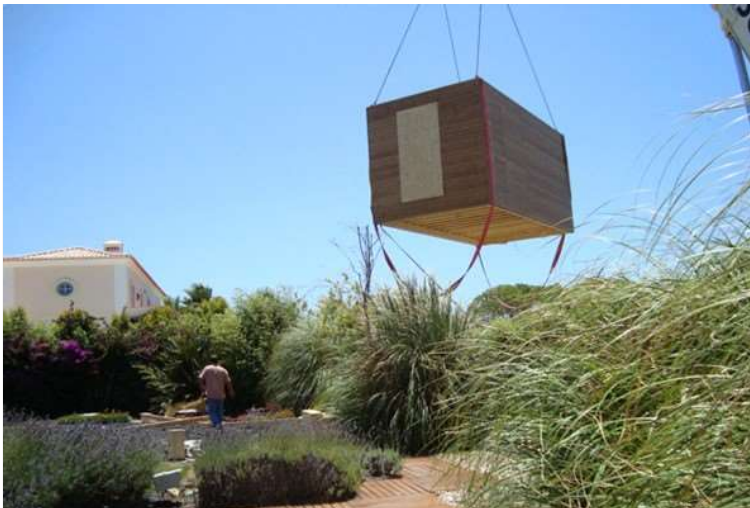
figura 52-módulo compacto a ser implantado
