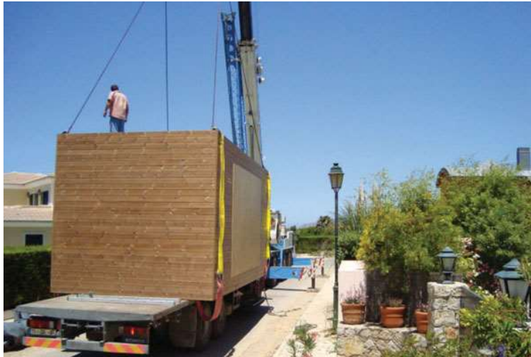
figura 53-módulo transportado por um camião
