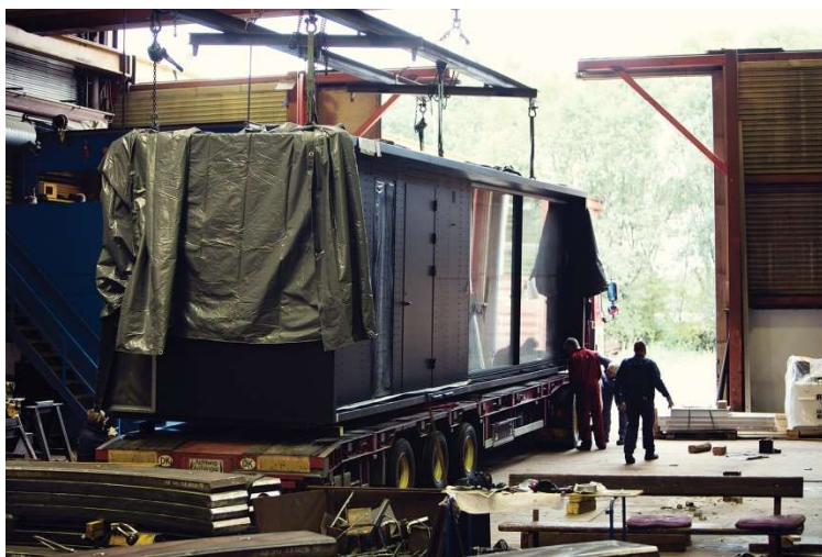
Figura 68-módulo transportado por um camião
