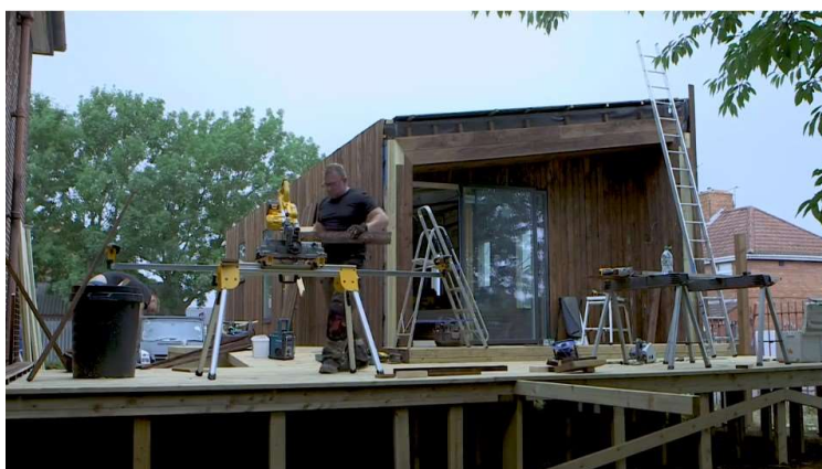
figura 34-estrutura dos arranjos exteriores da TAMHAUS
