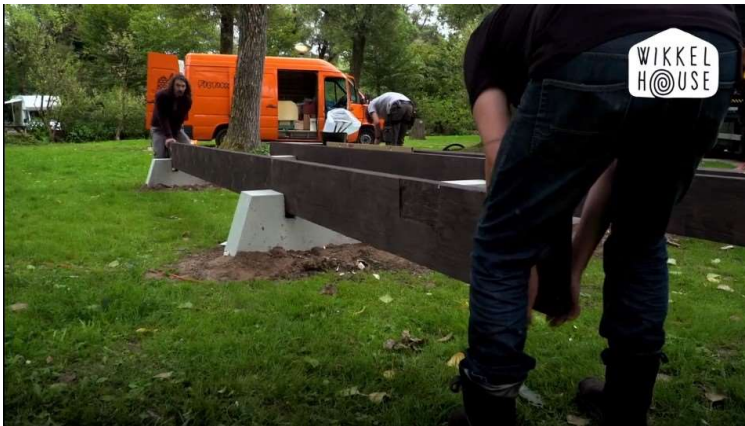
figura 84-sistema de fundações assente sobre vigas de betão
