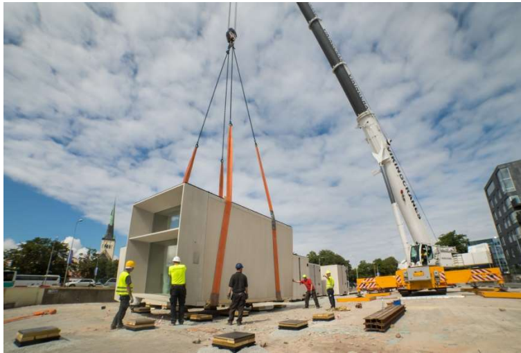
figura 71-implantação do módulo e sistema de apoios
