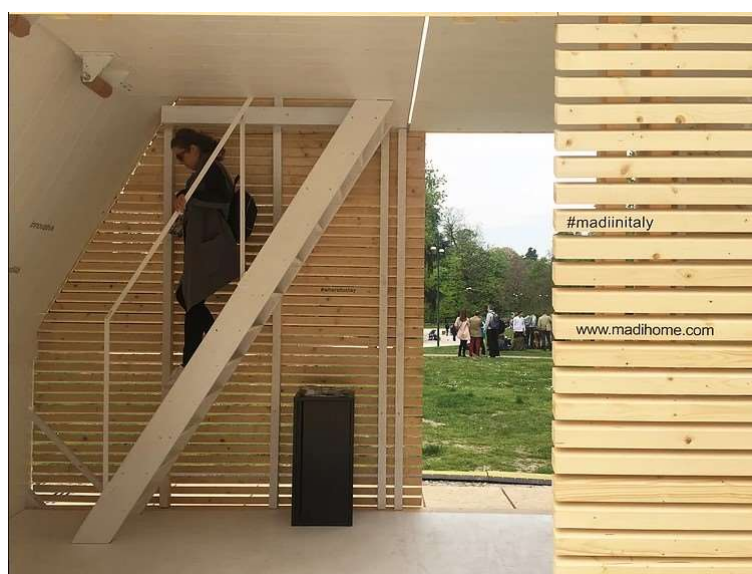
figura 48-excessiva inclinação dos acessos verticais
