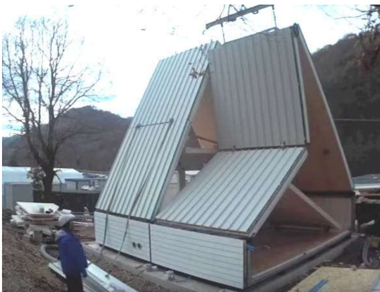
figura 43-montagem dos dois módulos para habitação
