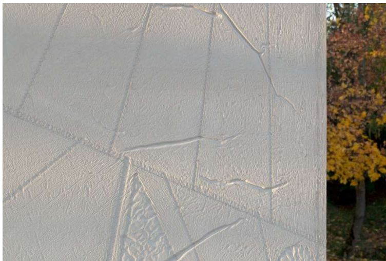
figura 74-revestimento dos painéis de betão em pormenor
