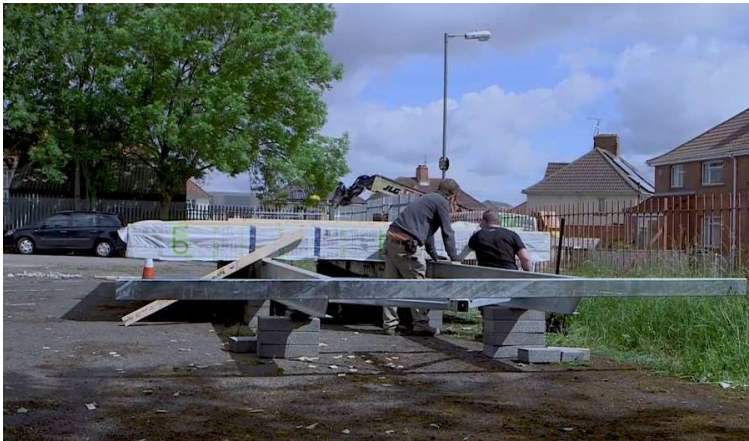
figura 35-solução das fundações adotada para situações mais permanentes
