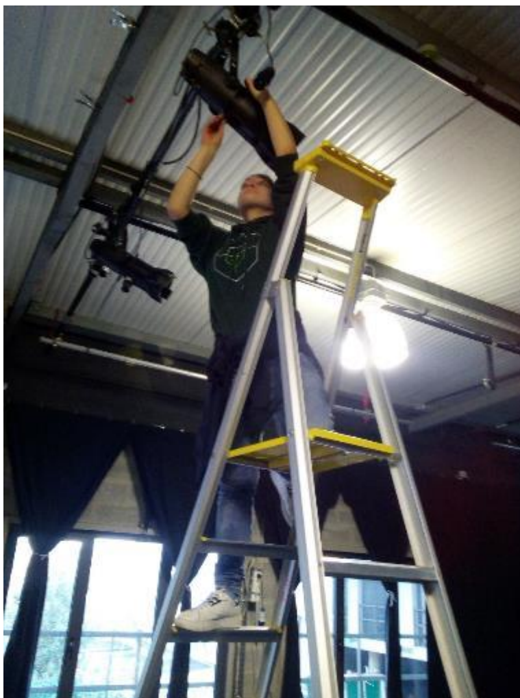
Figura 112 - Desmontagem de pin spots 2 (Foto: Daniela Gomes)
