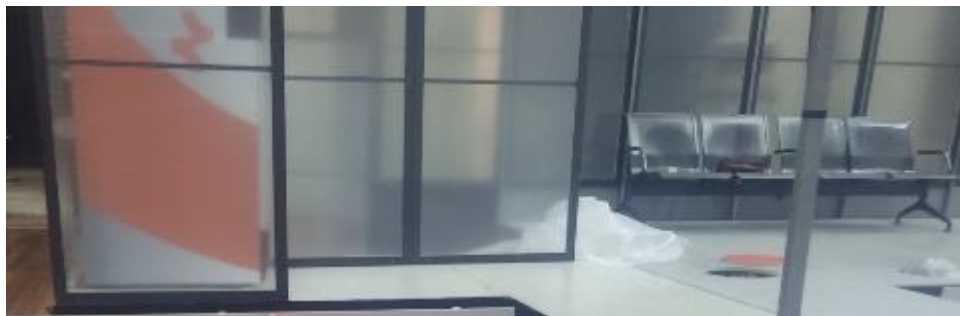
Figura 108 - Telas de fibra de vidro com tiras de madeira pretas (Foto: Eduardo Mendes)
