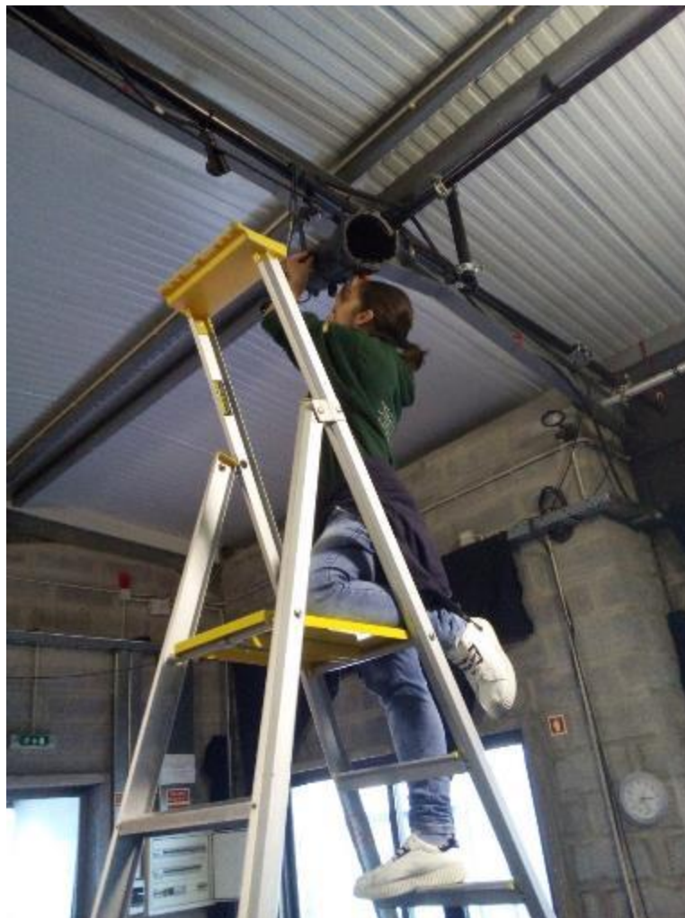
Figura 111 - Desmontagem de pin spots (Foto: Daniela Gomes)
