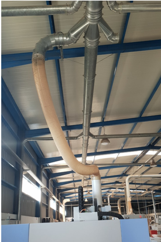
Figura 10: Conduitas de aspiração à esquerda e Cilo central à direita
