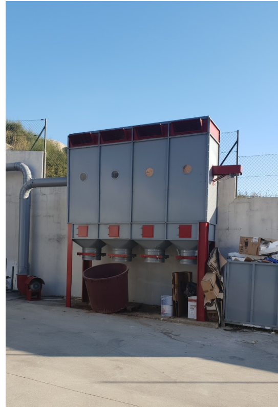
Figura 10: Conduitas de aspiração à esquerda e Cilo central à direita
