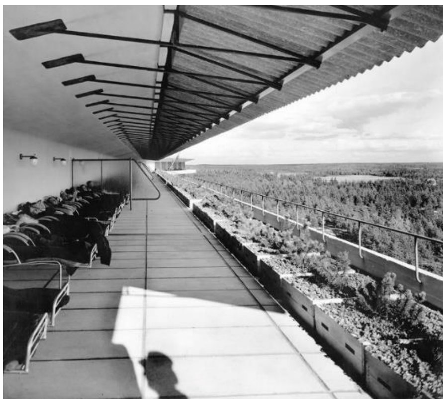
Figura 11 – “Terraço, com vista para a floresta, que se espalhava por toda a ala do edifício Sanatório Paimio, a fim de os pacientes descansarem e aproveitarem a luz do dia.” Fonte: 29
