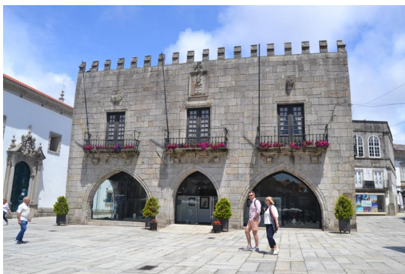
Edifício Paços do Concelho, Viana do Castelo
