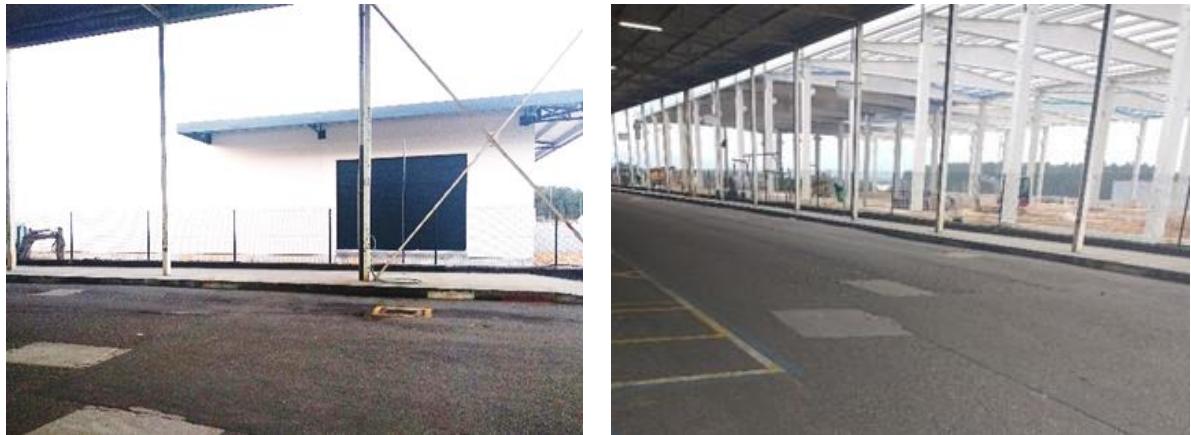
Figura 52 Cais de carga
