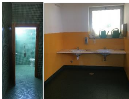
Figura 9. Wc e lavatórios
