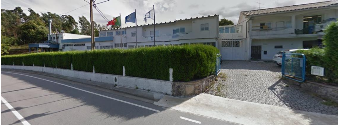
Figura 25 Visualização frontal da empresa situada em São Bento fonte: site https://www.google.pt/maps/ , visitado a março de 2020
