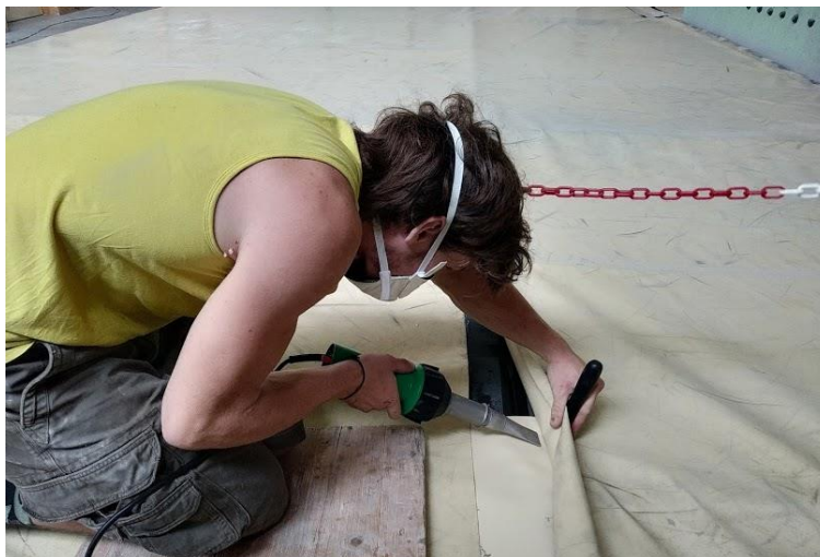
Figura 12 - Manutenção do Colchão
