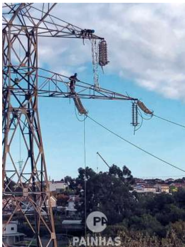
Figura 7. Desmontagem da linha Riba d'Ave, Vila Nova de Famalicão, Portugal
