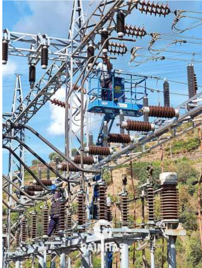
Figura 9. Montagem de ligações AT na Subestação Varosa (Edp Distribuição)
