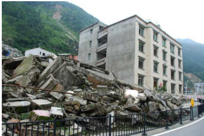
Figura 2.4: Sismo de 2008 em Wenchuan, edifícios em Beichuan, Sichuan, China.
