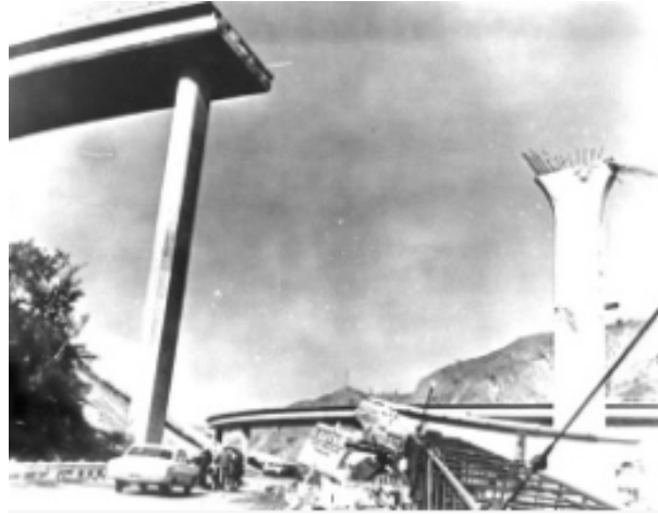
Figura 2.6: Colapso do Viaduto Newhall Pass (San Fernando, 1971).
