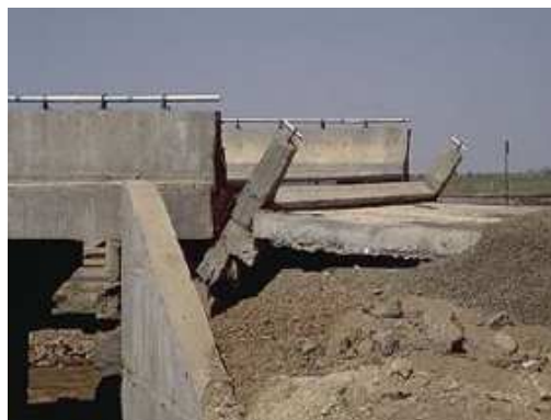
Figura 2.12: Impacto do tabuleiro sobre o encontro.
