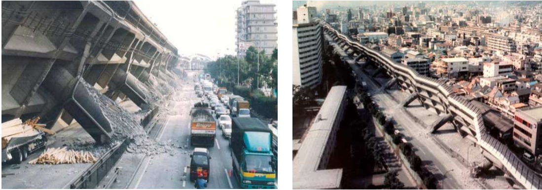
Figura 2.2: Viaduto do Hanshin Expressway após o sismo de Kobe em 1995.
