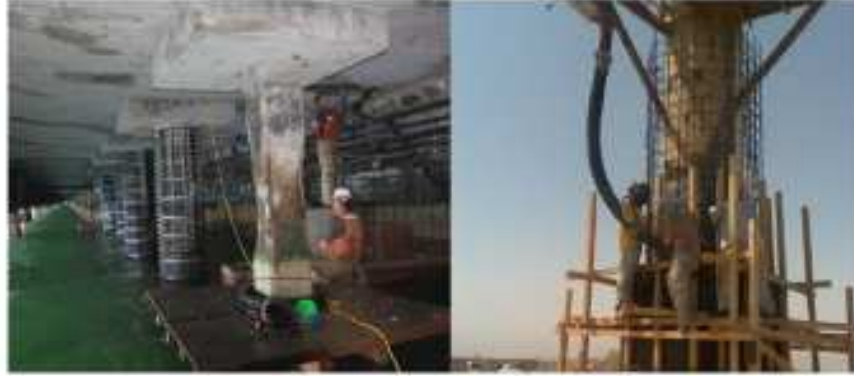
Figura 4.3: Encamisamento de pilares com betão armado (Santos, 2008)
