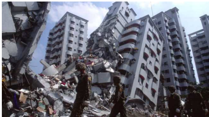
Figura 2.3: Danos ocorridos em prédios durante o sismo de 1999 em Chichi – Taiwan.
