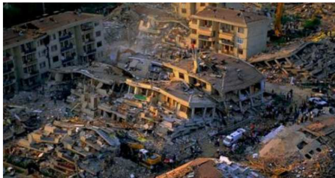
Figura 2.5: Imagem de casas totalmente destruídas na cidade de Izmit – Turquia.
