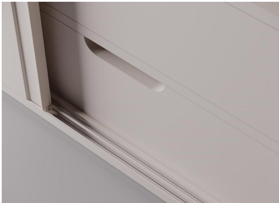
Figura 53- Exemplo de calhas metálicas aplicadas na parte inferior de um roupeiro (Foto do autor).
