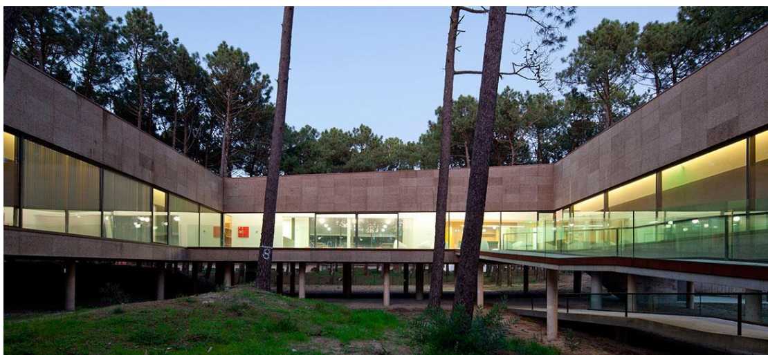
Figura 16 - Vista do exterior dentro do edifício do CAR (Centro de Alto Rendimento) Surf Club Viana - Fonte: Surf Clube Viana
