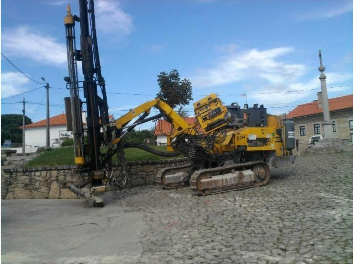
Figura 21 - Perfuradora para o desmonte de rocha
