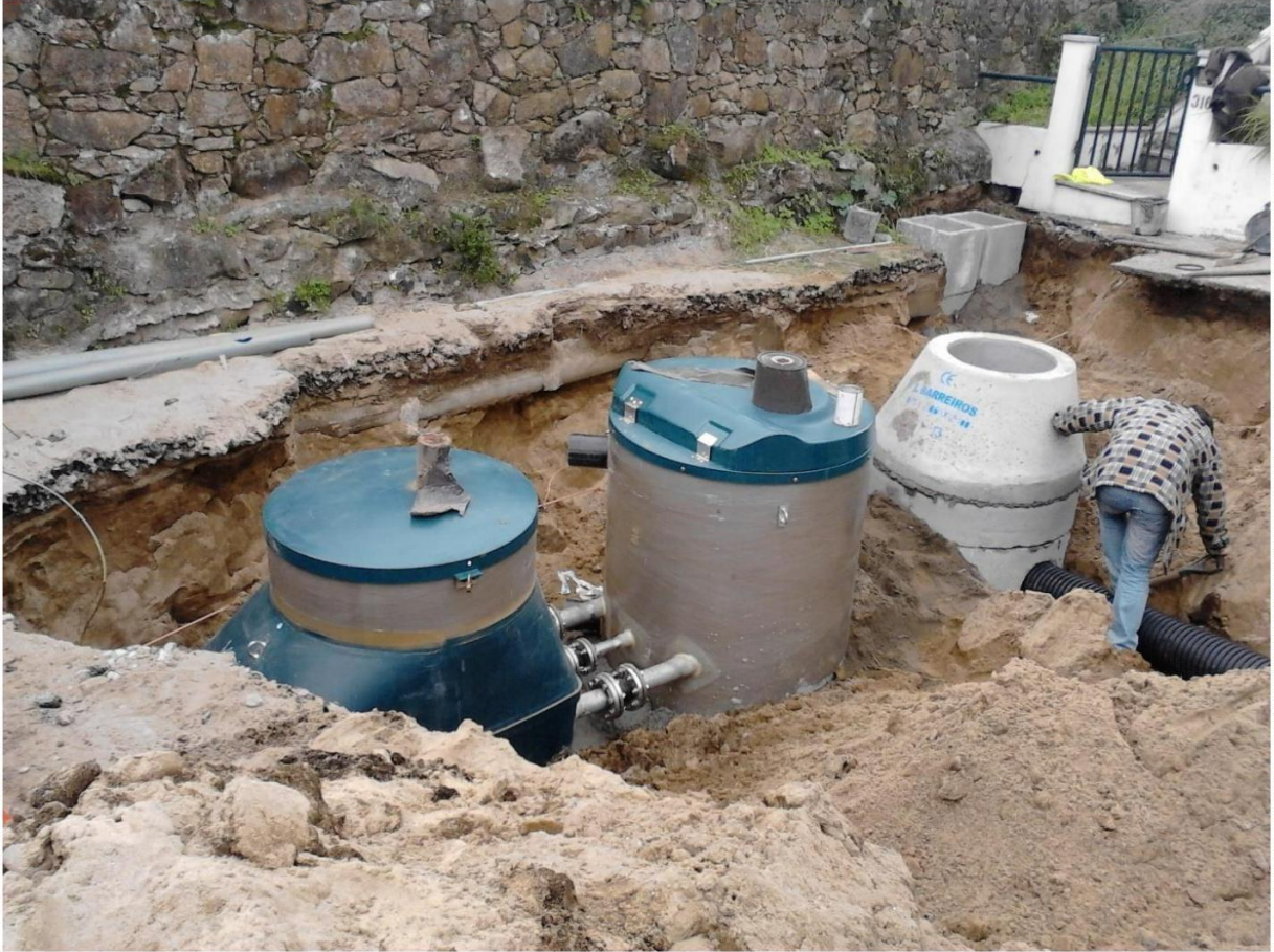
Figura 20 - Instalação de poços das estações elevatórias
