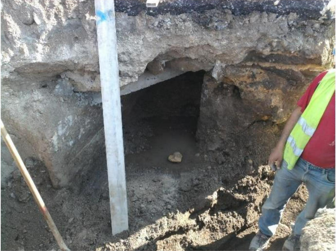
Figura 19 - Atravessamento de aqueduto pelo coletor
