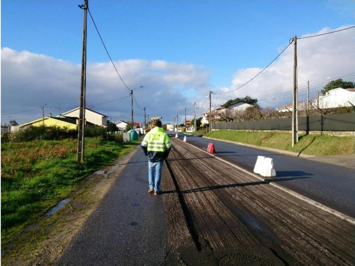
Figura 18 - Trabalhos de fresagem do pavimento
