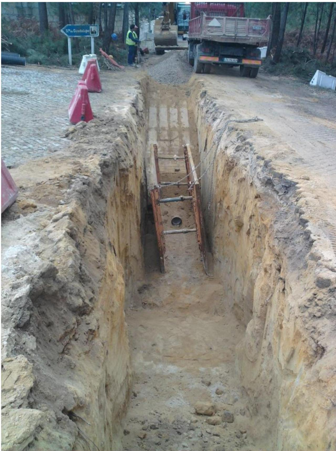
Figura 25 - Frente de trabalhos
