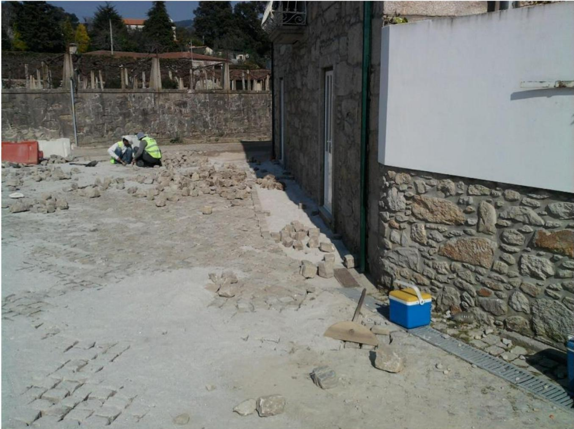
Figura 24 - Trabalhos de pavimentação em calçada
