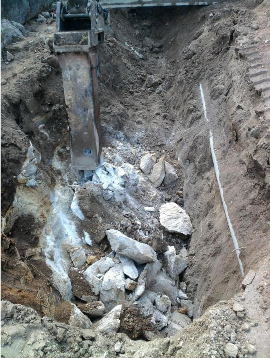
Figura 22 - Desmorte de rocha com uso do martelo hidráulico
