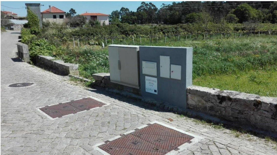
Figura 28 – EE implanta em arruamento de circulação automóvel
