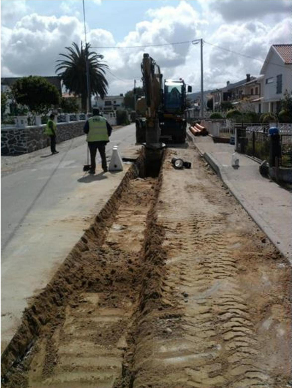
Figura 23 - Frente de trabalhos
