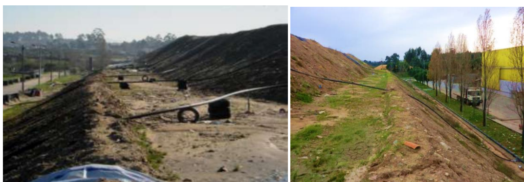
Fotografia 4.7 - Posicionamento das condutas secundárias de biogás no ASVC
