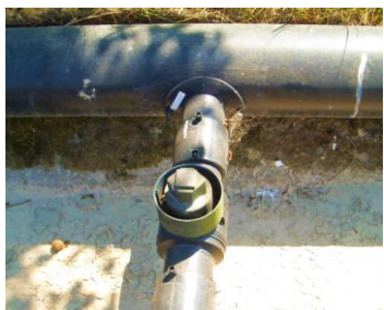
Fotografia 4.4 - Exemplo de válvula de ramal
