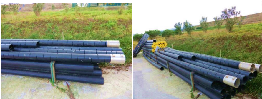
Fotografia 4.2 - Conduitas ranhuradas e união de aço utilizadas para implementar os poços verticais
