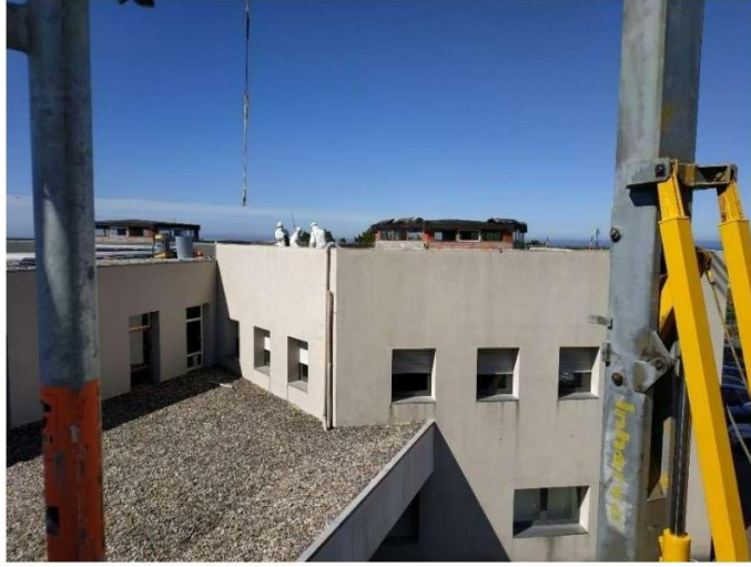
Figura 5 - Cobertura do Edifício e pormenor da grua
