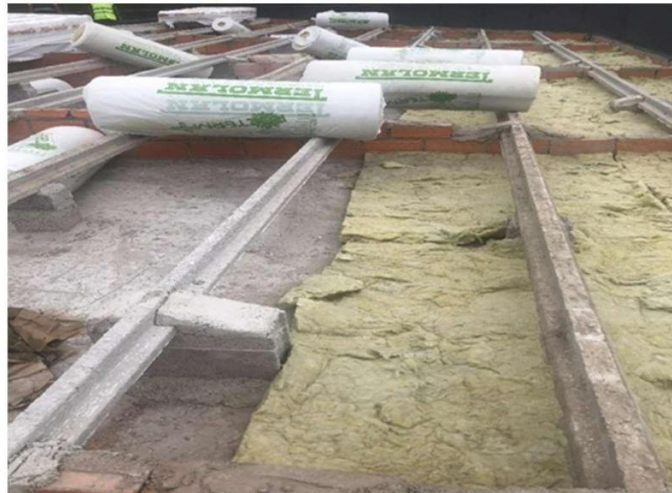
Figura 8 - Aplicação de manta em lã de rocha 40mm
