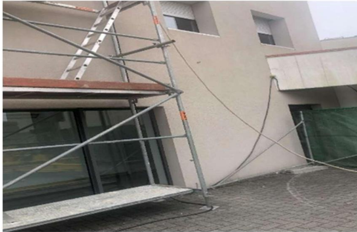
Figura 2– Pormenor do andaime
