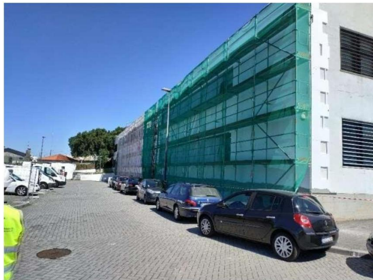
Figura 3 - Fachada do Edifício do andaime protegido.
