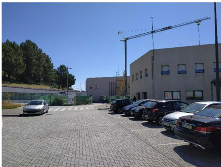
Figura 4 – Outro pormenor da fachada com a grua instalada
