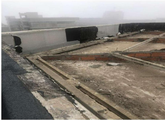
Figura 7 - Vista da Cobertura
