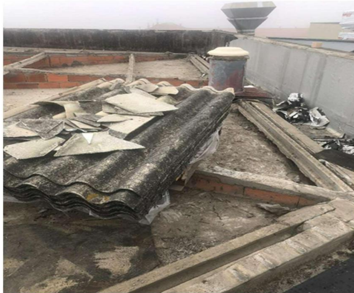
Figura 6 - Remoção de telhas em fibrocimento
