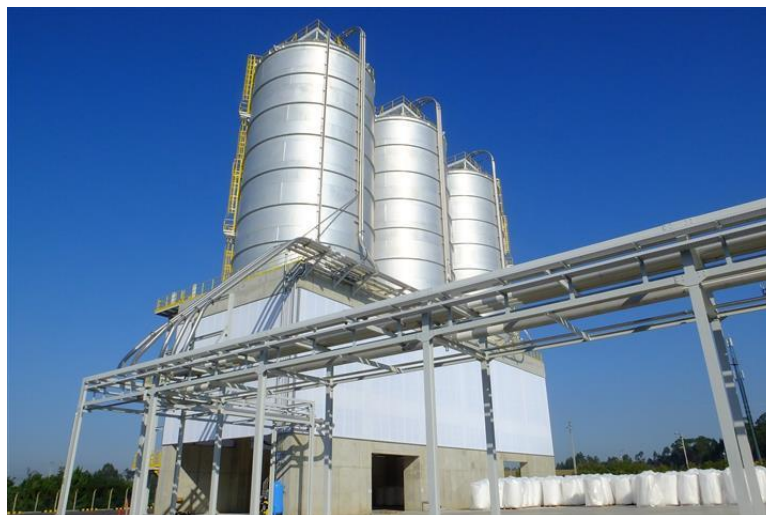
Figura 44_ Silos de armazenamento de PVC - Shin Etsu, Cires (Cimave Construções, 2014)
