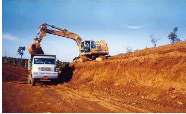
Figura 28_ Remoção da camada superficial (Rodrigues, 2008)
