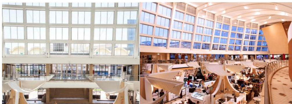
Figura 36_ Caixilharia no Mercado Bom Sucesso do Porto
