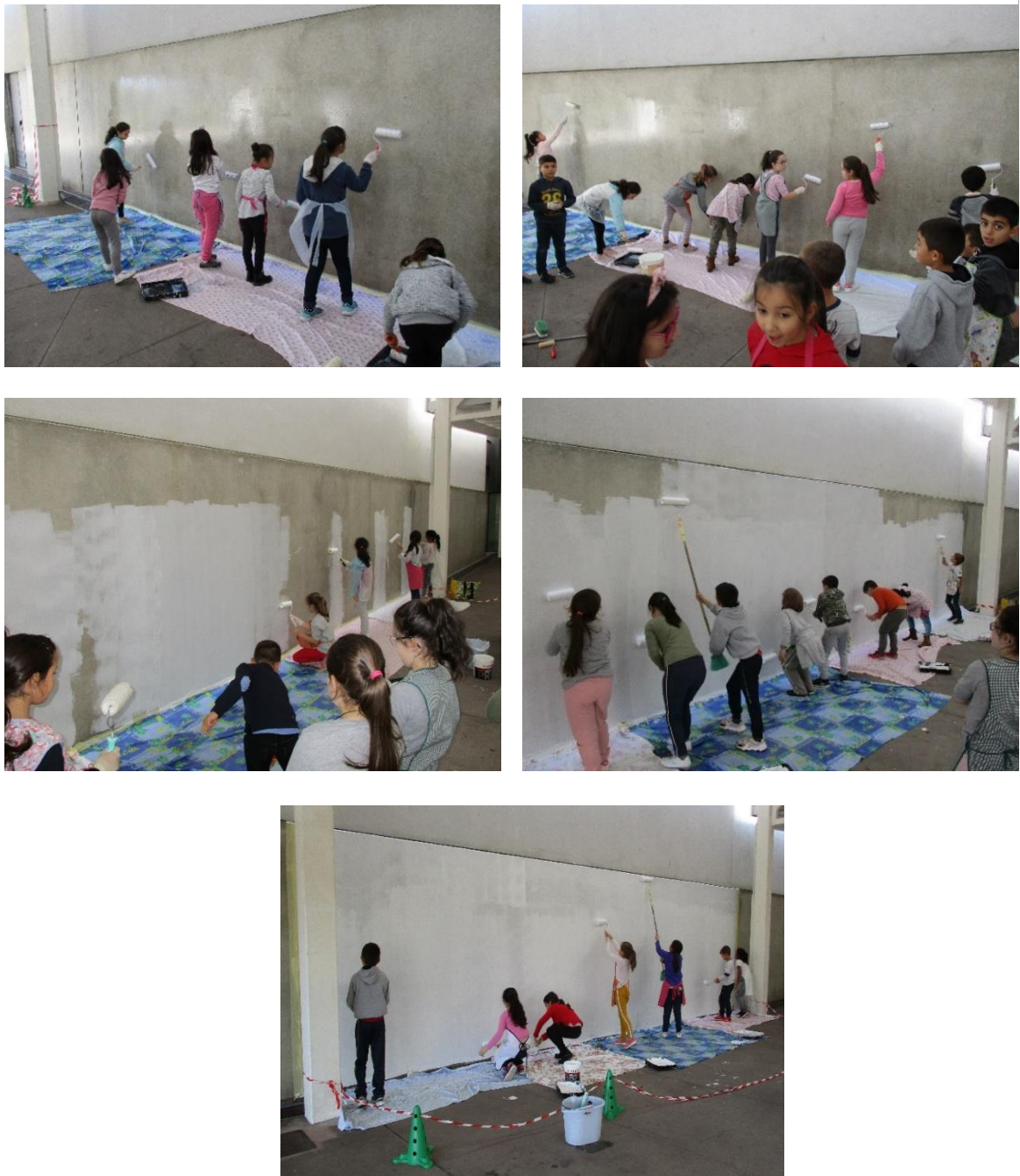
Figura 5- Colocação do primário e primeira cor
