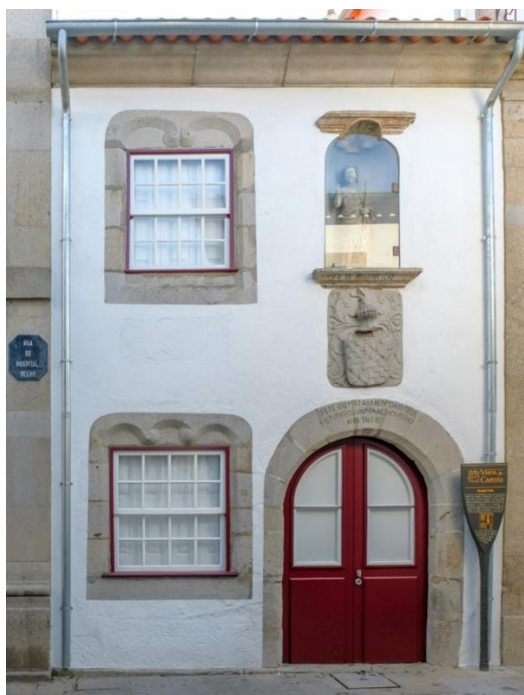
Figura 18: Fachada do Hospital Velho, atual cada do Centro Interpretativo do Caminho Português da Costa (foto própria)
