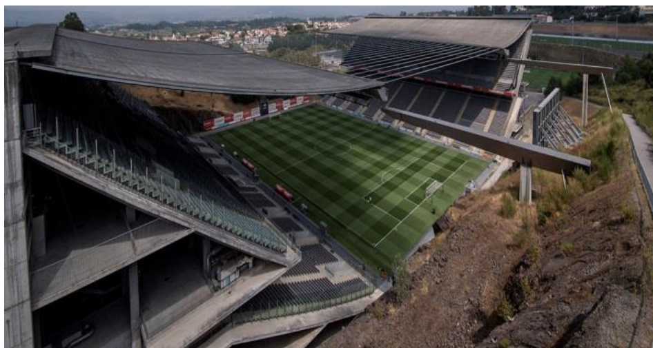
Figura 1- Vista aérea, estádio Sporting Clube de Braga
