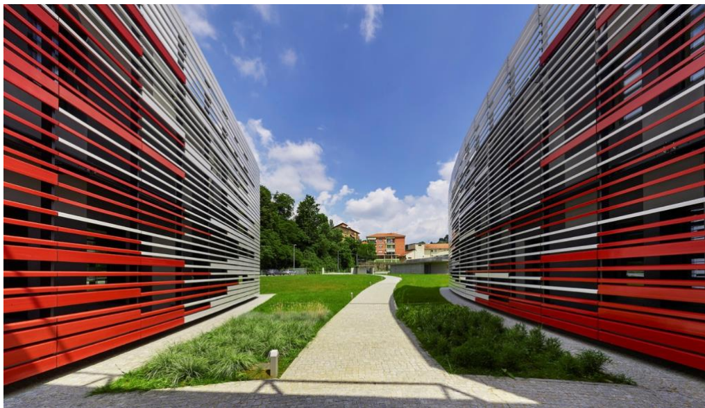
Figura 3 – Fachada ventilada com diferentes formas [10].
