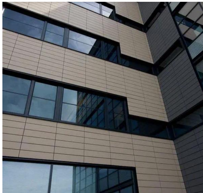
Figura 21 – Fachada ventilada com revestimento feito em placas cerâmicas [70].
