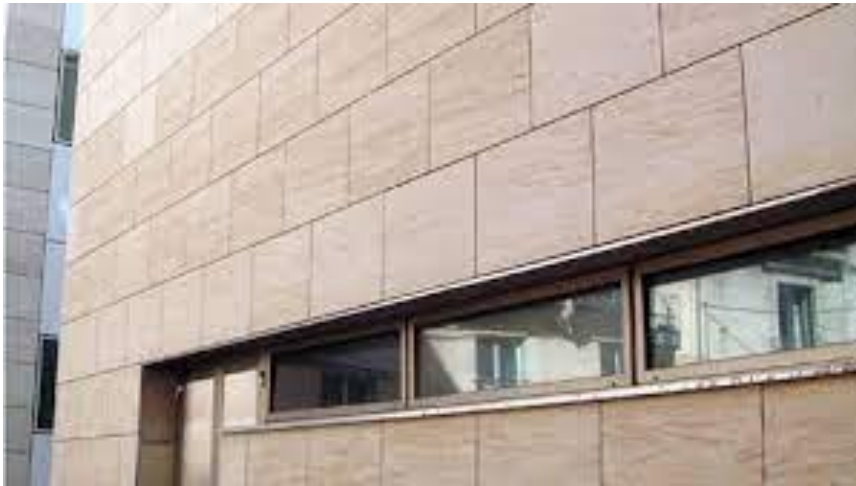
Figura 20 – Fachada ventilada com revestimento feito em placas de pedra natural [69].
