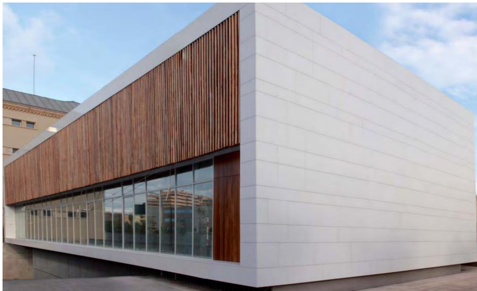
Figura 25 – Fachada ventilada com revestimento feito em placas de pedra artificial à base de mármore e quartzo [74].
