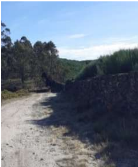
Figura 11 - Muro do Fojo
