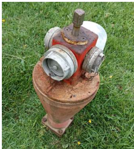
Figura 6.10 - Hidrante exterior
