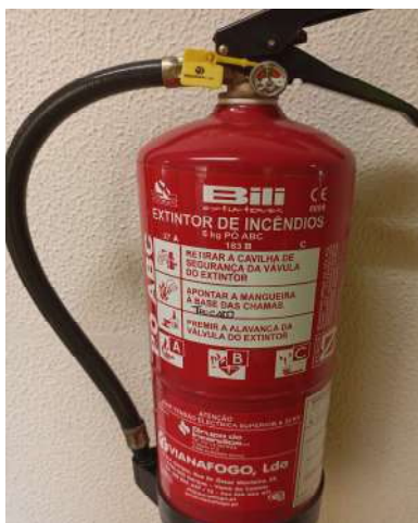
Figura 6.8 - Extintor de pó químico ABC
