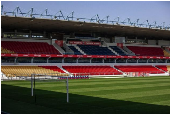
Figura 2 – Estádio Cidade de Barcelos
