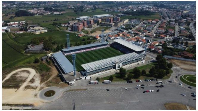
Figura 3 – Estádio Cidade de Barcelos
