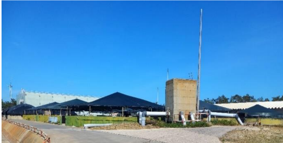
Figura 3.7: Tanques pré-engorda. Fonte: Fotografia original (2022).
