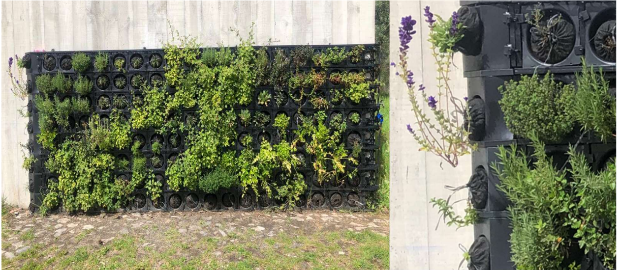
Figura 3.1. Jardim Vertical (Sistema WallGreen, da LandLab) instalado na Escola Superior Agrária do Instituto Politécnico de Viana do Castelo.
