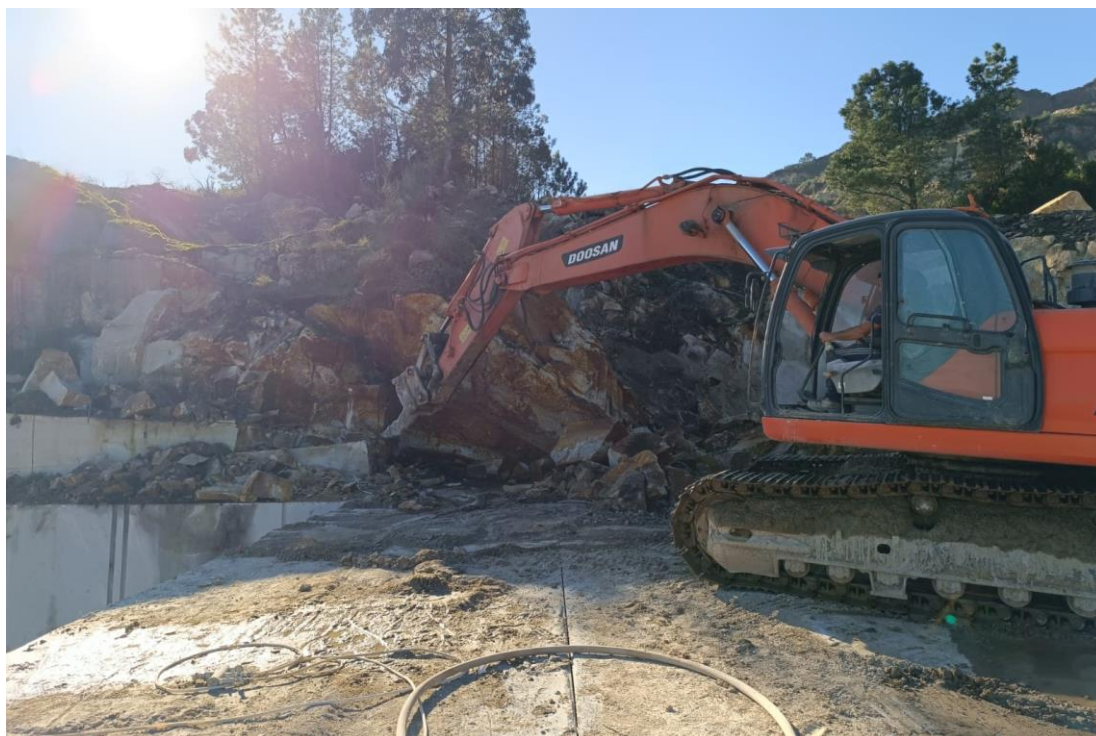
Figura 3.4: Fase de remoção de vegetação e terras da cobertura
