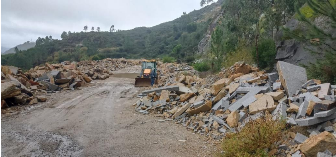
Figura 3.7: Depósito de material para britagem
