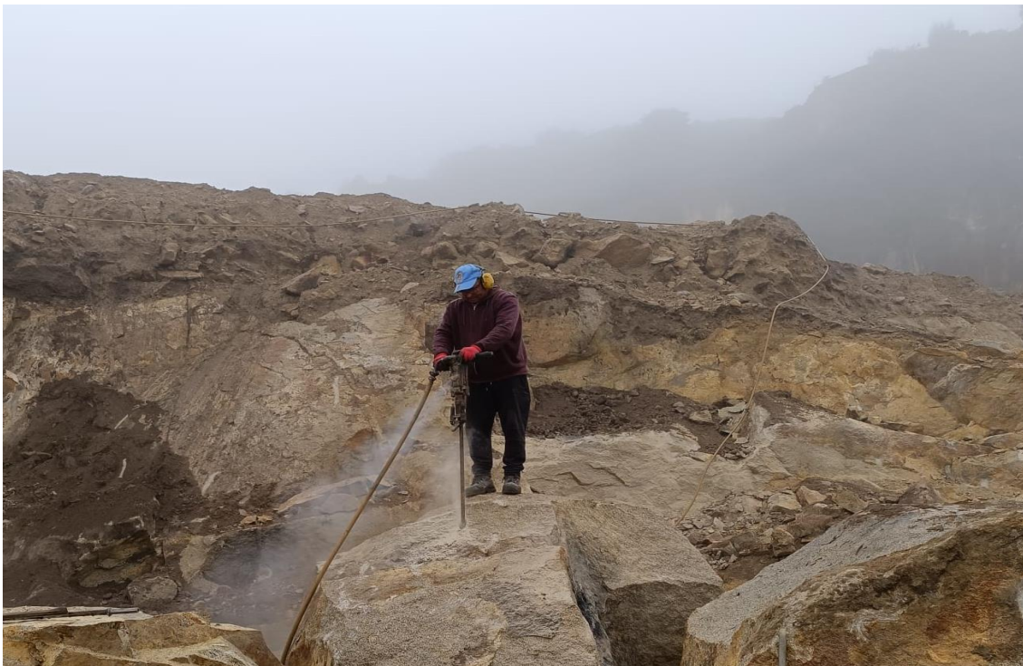
Figura 3.5: Furação mecânica com martelos pneumáticos
