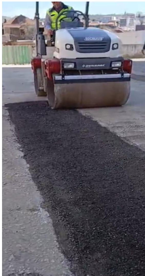
Figura 3.7: Processo de compactação (Alcomoa engenharia e serviços)
