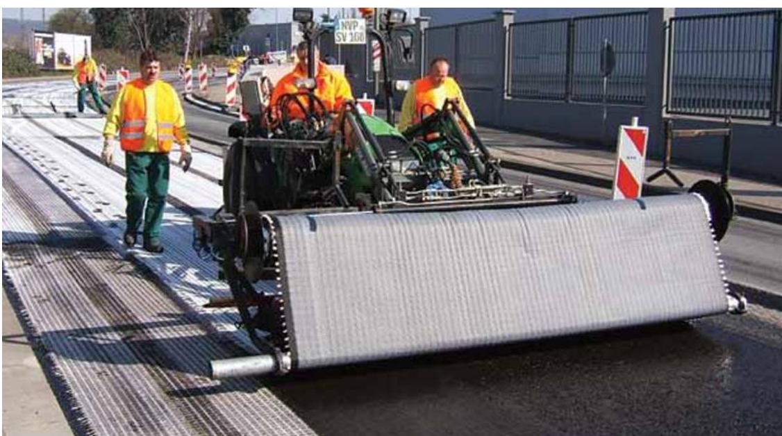
Figura 2.12: Aplicação mecânica do geotêxtil impregnado com emulsão betuminosa (Pavimentos asfálticos, Tensar)
