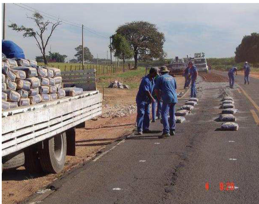
Figura 3.5: Espalhamento manual de cimento (Arrieiro 2007)
