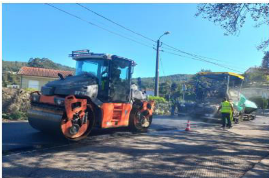
Figura 4.9: Aplicação da nova mistura betuminosa (Socorpena, engenharia e construções)
