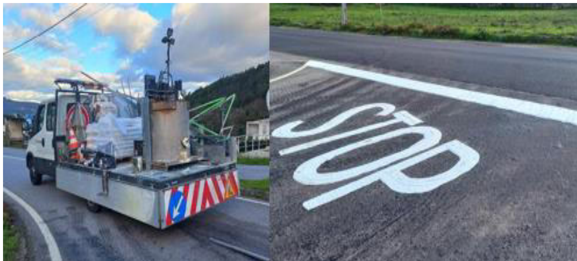
Figura 4.11: Sinalização horizontal prevista no projecto (Socorpena, engenharia e construções)
