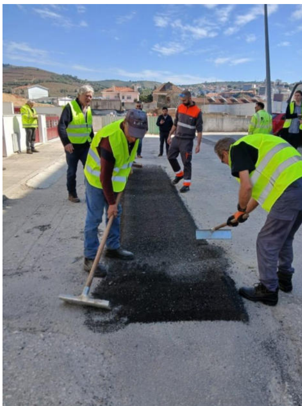
Figura 3.6: Espalhamento da mistura (Alcomoa engenharia e serviços)
