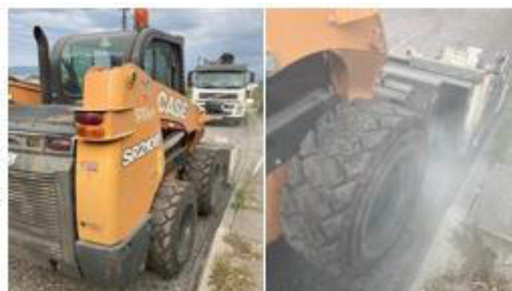
Figura 4.6: Limpeza com recurso a mini pá carregadora (Socorpena, engenharia e construções)
