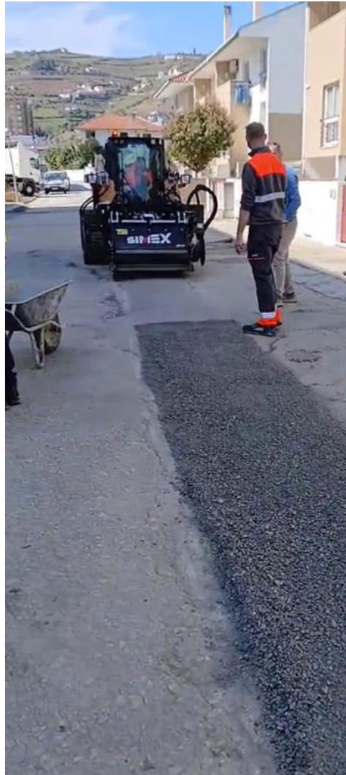
Figura 3.2: Processo de micro fresagem de um pavimento (Alcomoa engenharia e serviços)
