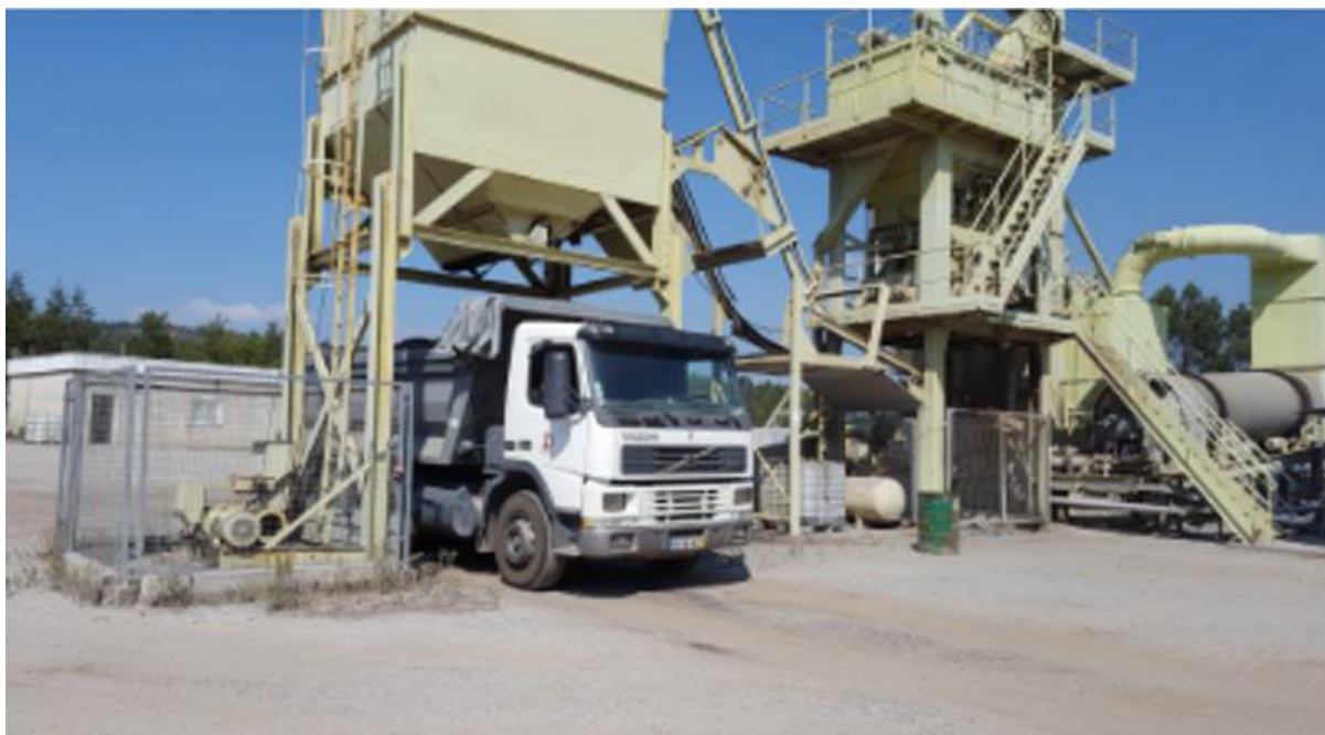
Figura 4.2: Central betuminosa (Socorpena, engenharia e construções)
