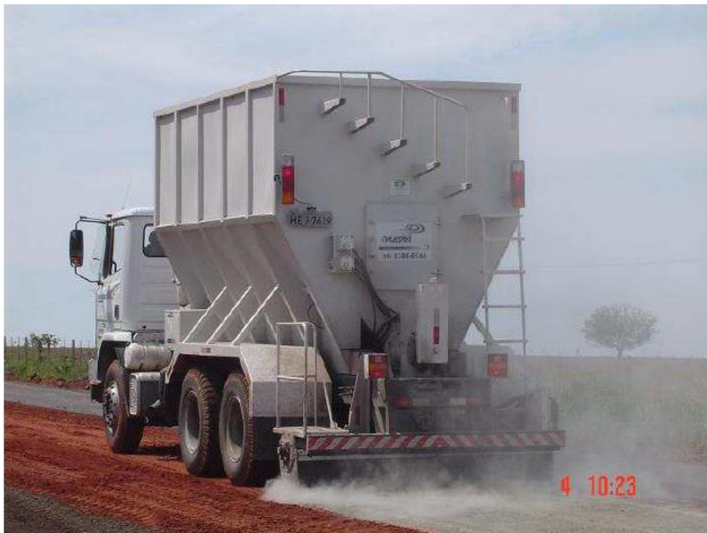
Figura 3.4: Espalhamento mecanizado de cimento (Arrieiro, 2007)
