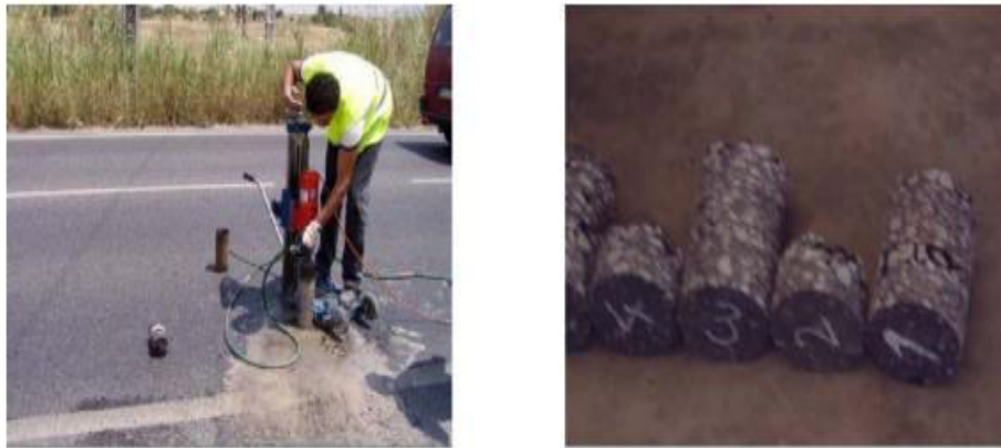
Figura 2.1: Execução de sondagem de rotação [Fontul, 2007] e tarolos retirados de um pavimento flexível
