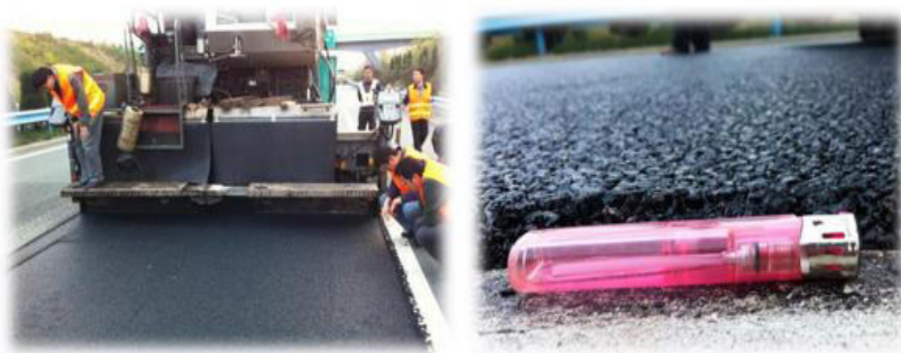
Figura 2.9: Aplicação de microaglomerado betuminoso a frio (adaptado de Go Green 2012)
