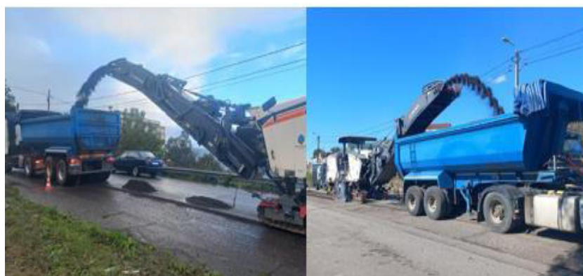
Figura 4.8: Remoção dos resíduos e encaminhamento para o local autorizado (Socorpena, engenharia e construções)
