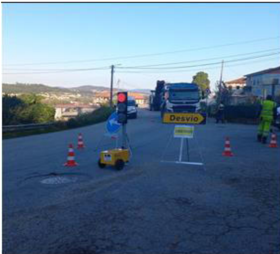
Figura 4.10: Semaforização para alteração na circulação rodoviária (Socorpena, engenharia e construções)
