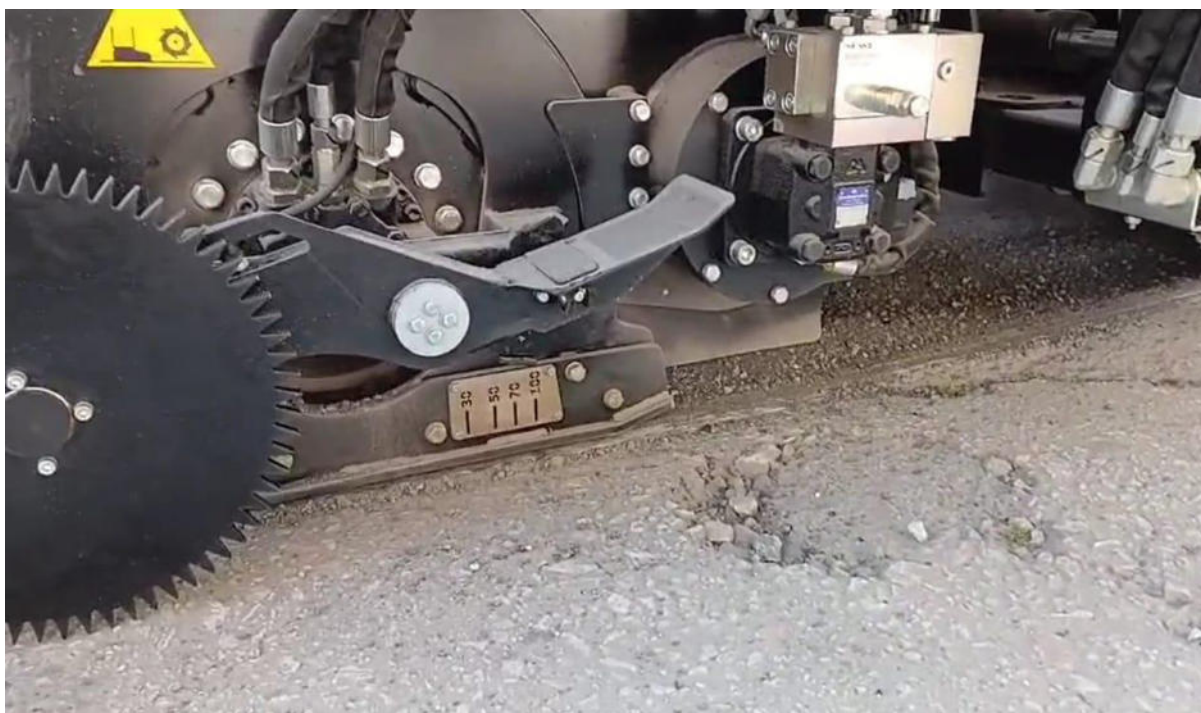
Figura 3.3: Pormenor da mistura de aditivos (Alcomoa engenharia e serviços)
