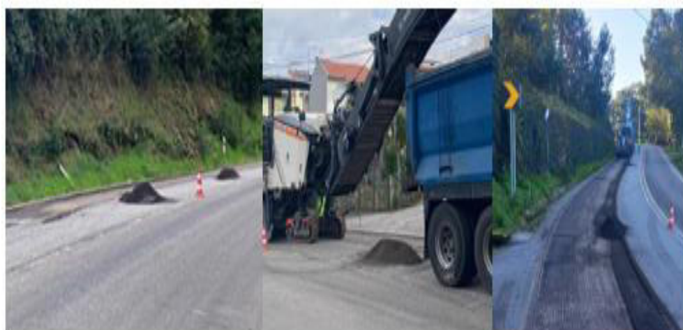
Figura 4.7: Armazenamento de resíduos proveniente da fresagem, dentro da via intervencionada (Socorpena, engenharia e construções)
