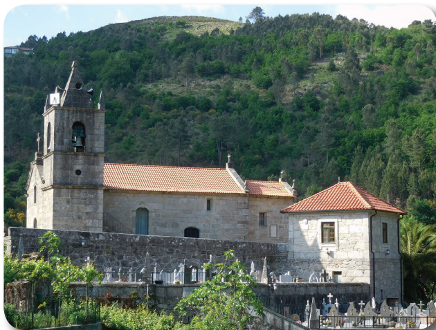
Figura 3. Igreja e Cemitério do Lugar de Igreja, freguesia de Sistelo.
